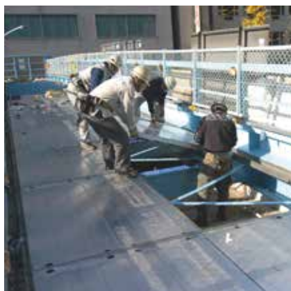
⑥人力による設置
