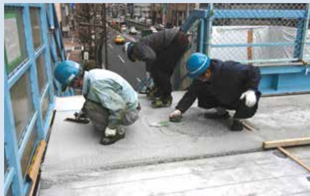
薄層舗装状況
