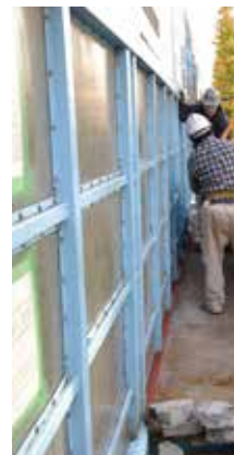
④重機によりアル
