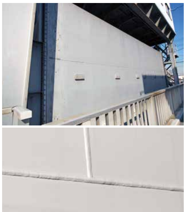
現場溶接された実績です。
