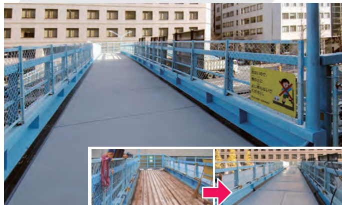
改修前／鋼製床版
