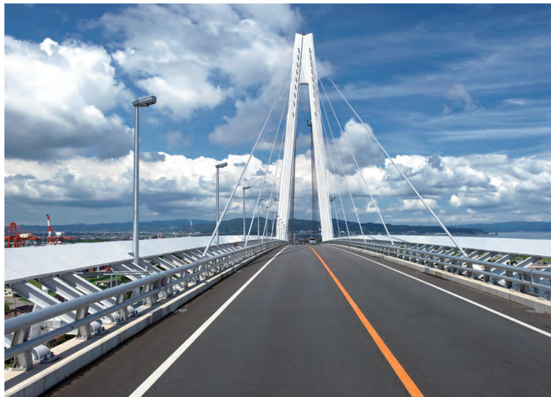
新湊大橋/富山県 種別:抑流板 タイプ:アルミろう付けハニカムパネル 工事:新設
