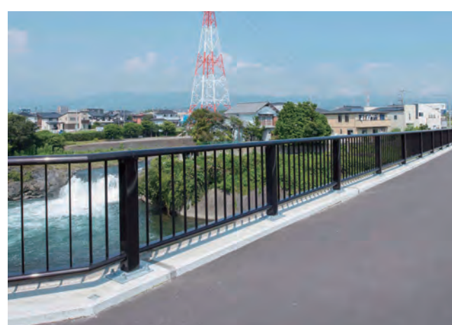
鎧ヶ淵大橋 / 静岡県 種別: ハイテンション型高欄 タイプ: アルミ合金製・標準 工事: 新設
