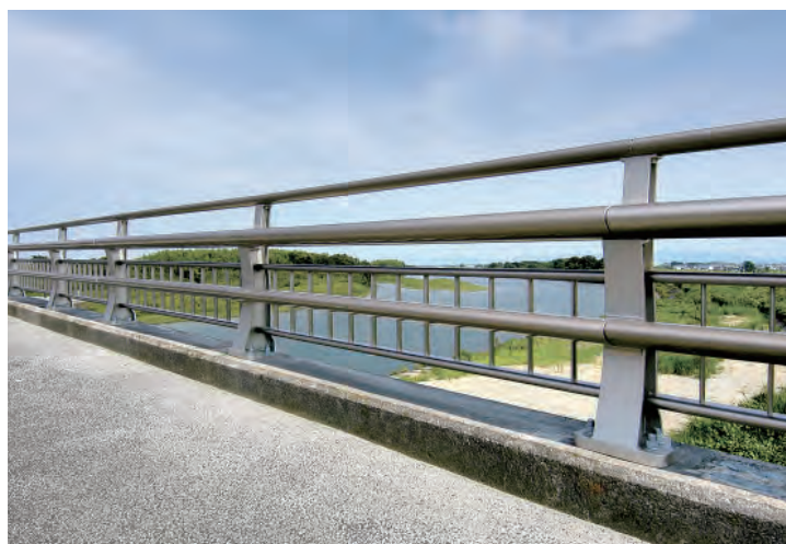
改修後 A種アルミ合金製高欄兼用車両防護柵
