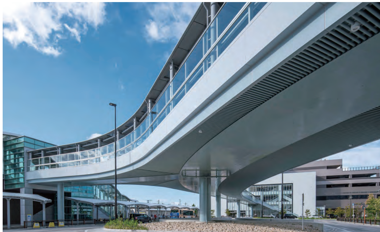
岸辺駅北公共通路／大阪府 桁側面:アルミパネル・桁下面:アルミルーバー 工事:新設
