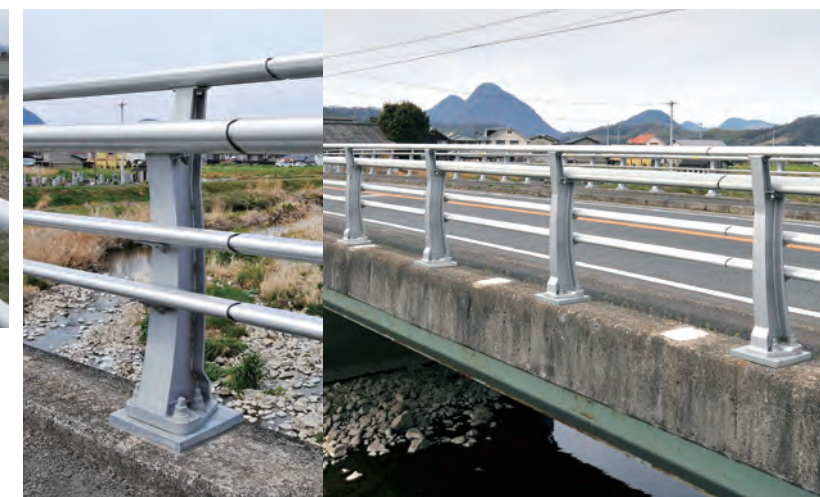
改修後 C種アルミ合金製車両防護柵
