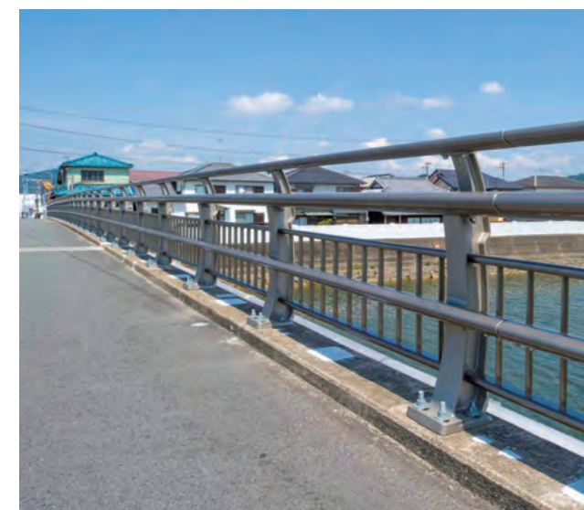
元川橋／兵庫県 種別:C種 タイプ:キャブロー 工事:改修
