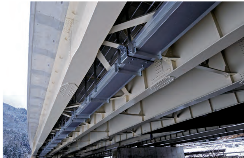
下熊谷川橋/岡山県 上部構造検査路
