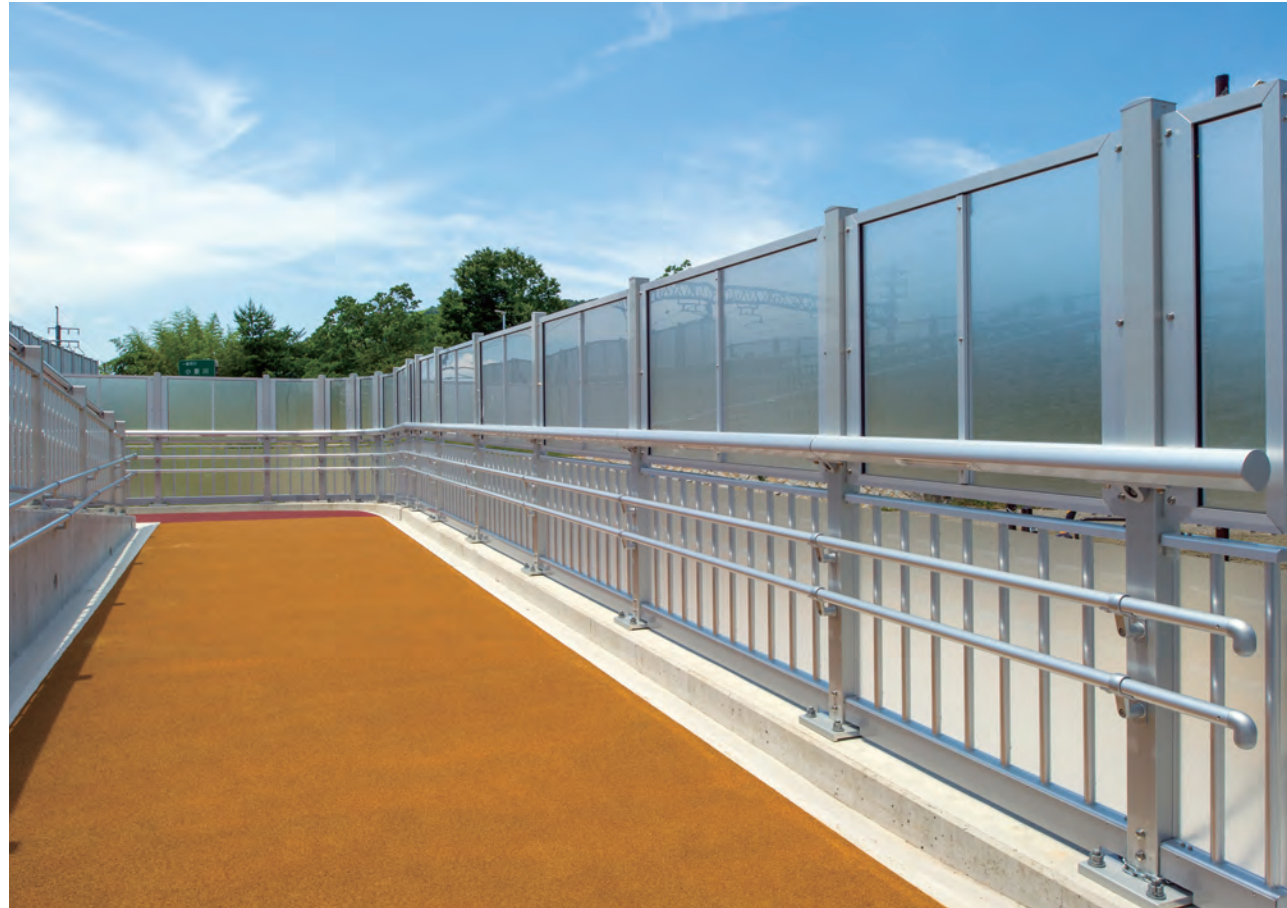
長慶橋/京都府 種別: SP種 タイプ: アルミ合金製+落下物防止柵+二段手摺 工事: 新設
