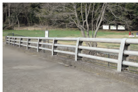
改修前 アルミ合金製高欄
