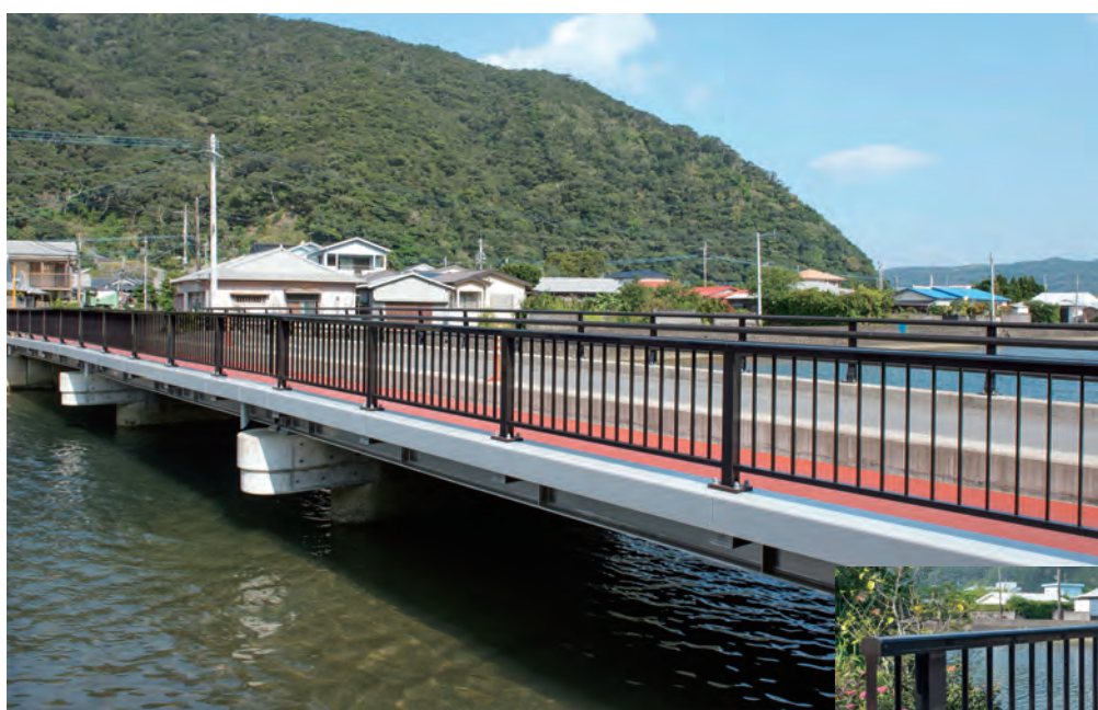
大和橋／鹿児島県 アルミ歩道拡幅床版(鋼橋ブラケット方式)・ 高欄:アルミ合金製SP種
