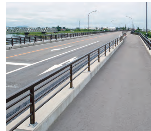
美川大橋/石川県 種別:P種 タイプ:アルミ合金製標準 工事:新設
