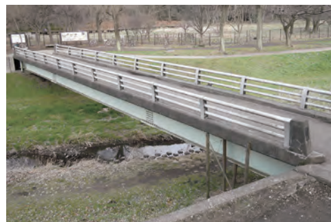
改修前 アルミ合金製高欄
