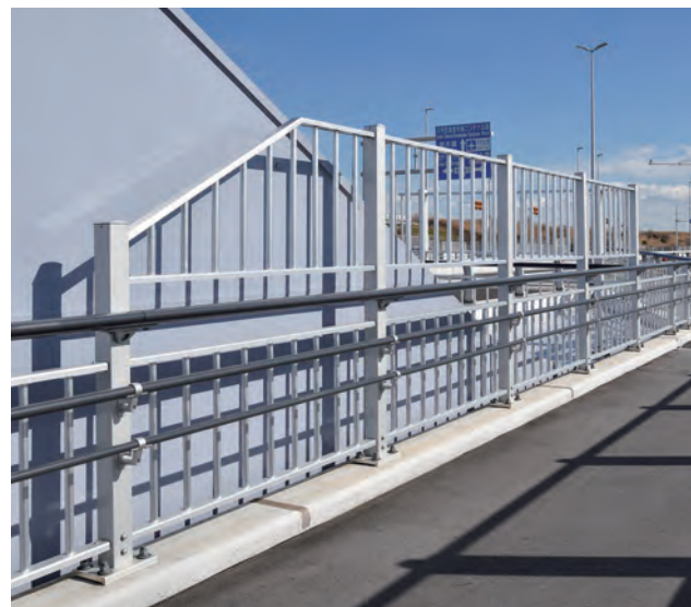
海の森大橋/東京都 種別: SP種 タイプ:アルミ合金製+侵入防止+二段手摺 工事:新設
