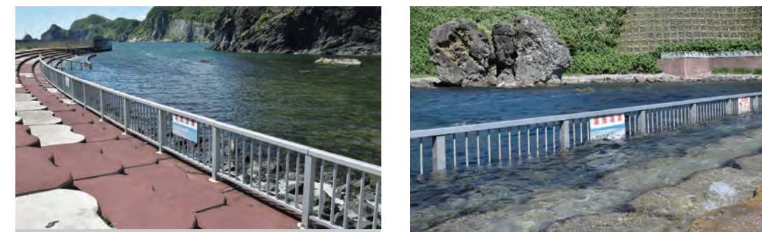
海浜地帯 追直漁港(おいなおしぎょう)護岸高欄／北海道 平成21年設置→平成30年撮影(9年経過)
