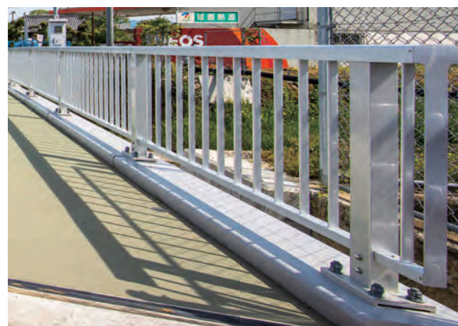
堂山橋 / 熊本県 種別: SP種 タイプ: アルミ合金製・標準 工事: 新設
