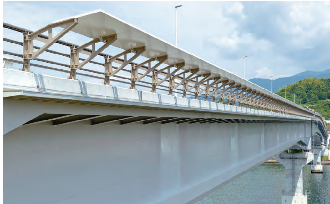
九島大橋/愛媛県 種別:抑流板 タイプ:アルミろう付けハニカムパネル 工事:新設
