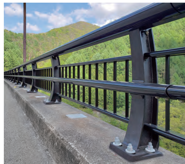
鶏冠山大橋／山梨県 種別:B種 タイプ:キャブロー 工事:改修
