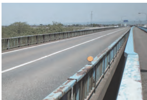
改修前 鋼製高欄
