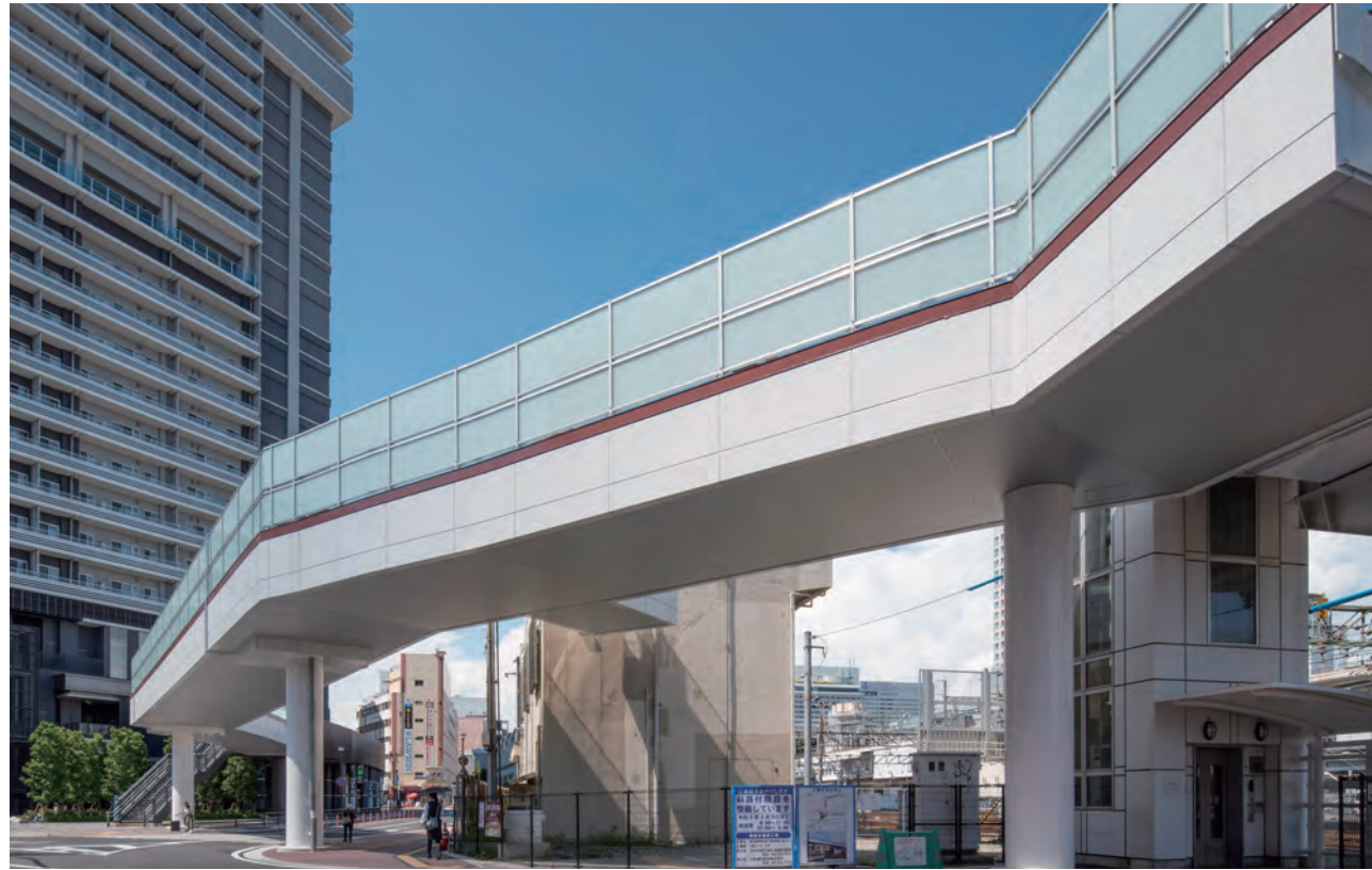
広島駅愛宕デッキ／広島県 桁側面:アルミパネル・桁下面:アルミスバンドレル 工事:新設
