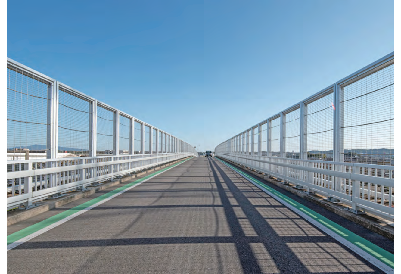
阿原跨線橋／愛知県 種別:積荷転落防止柵(F1) タイプ:アルミ合金製 工事:改修
