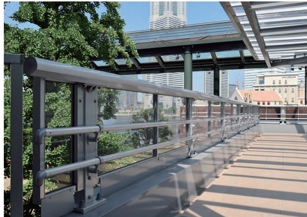
横浜エアキャビン新港地区連絡通路/神奈川県 種別: SP種 タイプ:アルミ合金製+二段手すり 工事:新設
