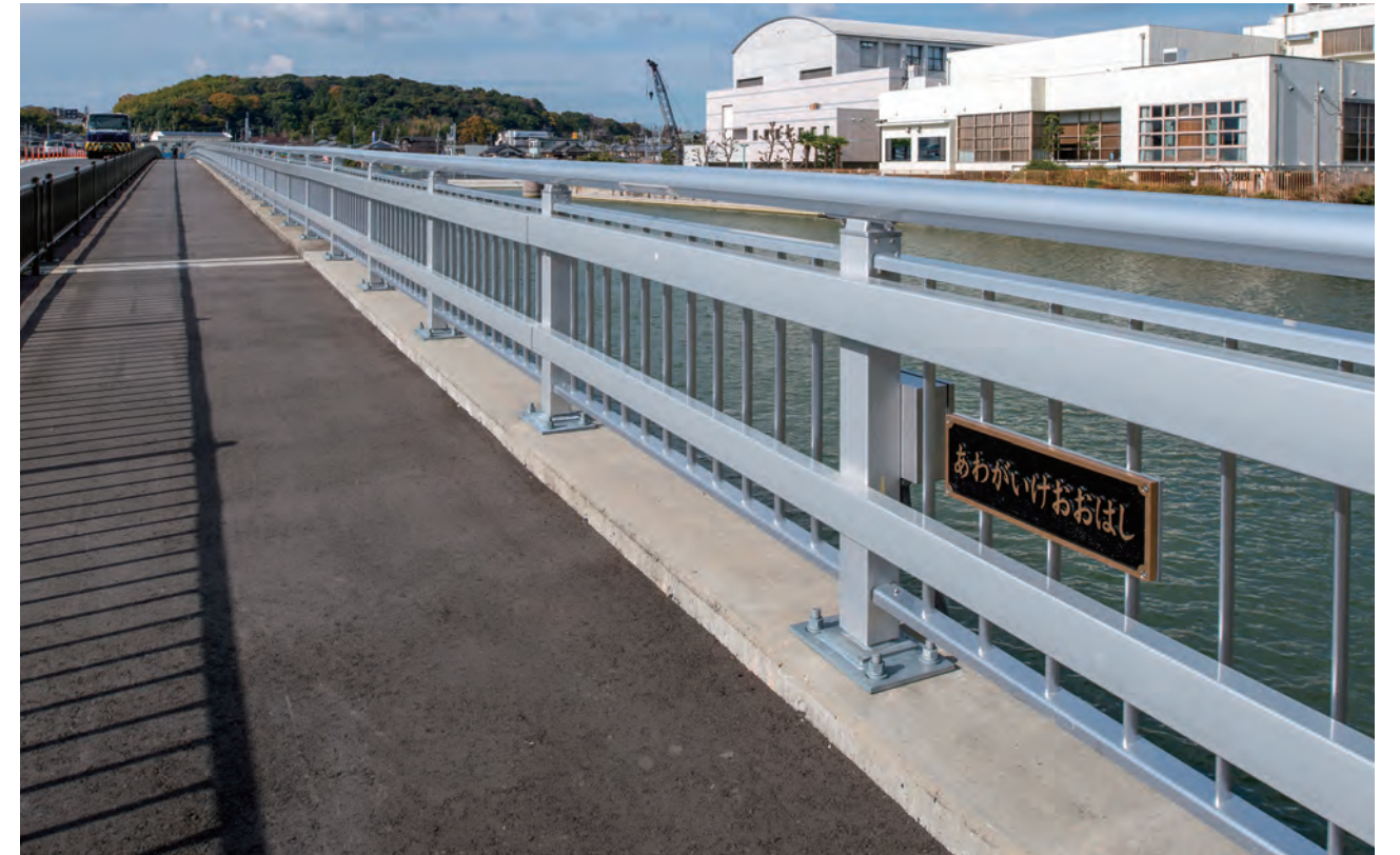
粟ヶ池大橋/大阪府 種別: B種 タイプ: アルミ合金製標準(改) 工事: 改修
