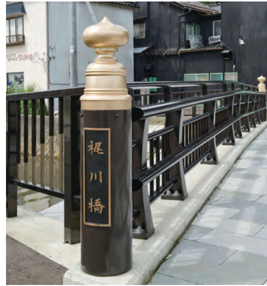
梶川橋／石川県 アルミ合金製+アルミ合金製鋳物
