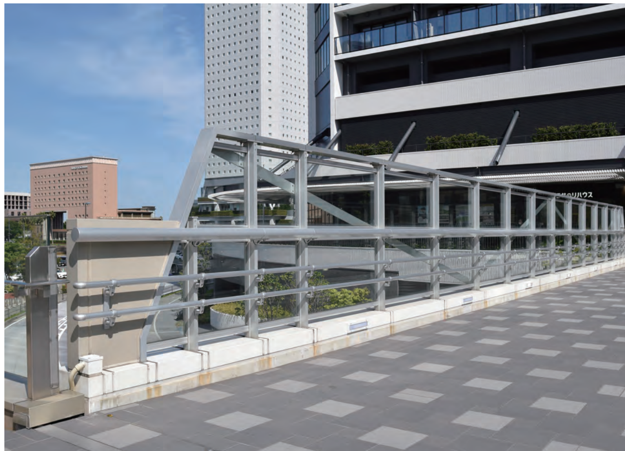
北仲デッキ/神奈川県 種別: SP種 タイプ: アルミ合金製+落下物防止柵+二段手摺 工事: 新設
