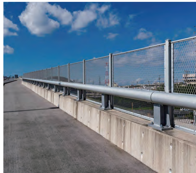
浦添西原大橋／沖縄県 種別:SB種 タイプ:アルミ合金製+落下物防止柵 工事:新設
