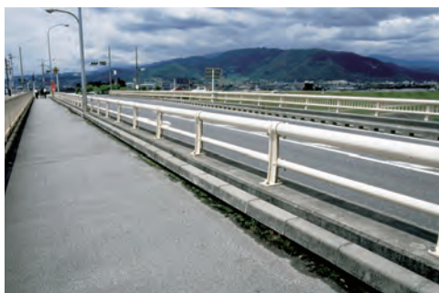
改修前 鋼製防護柵
