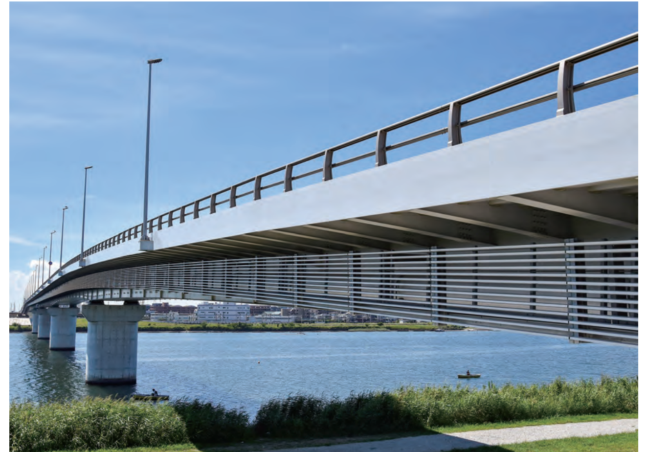
妙典橋／千葉県 桁側面:アルミルーバー 工事:新設
