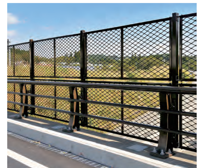
二本柳橋/青森県 種別:B種 タイプ:キャブロー+落下物防止柵(アンブリシェイブ) 工事:改修
