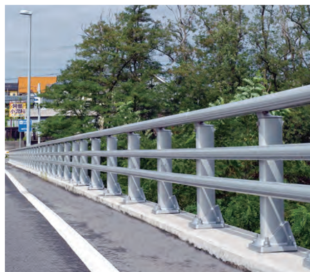
大正橋/新潟県 種別:B種 タイプ:アスレール 工事:改修
