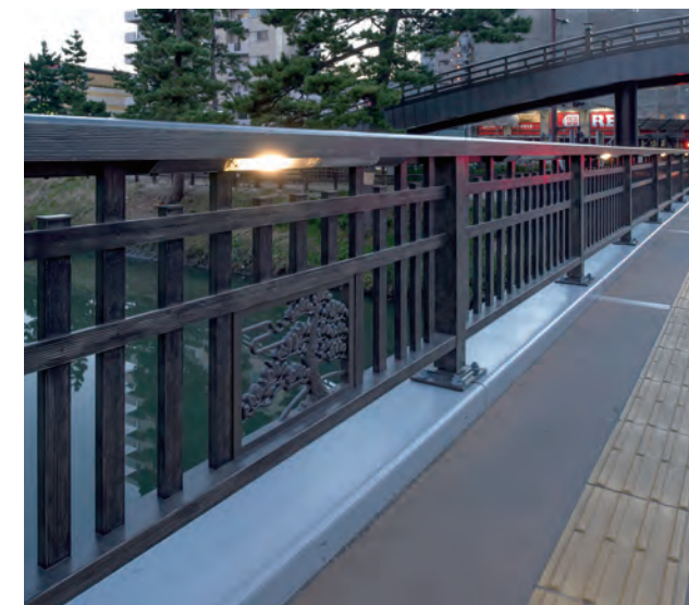
松原大橋/埼玉県 種別: ハイテンション型高欄 タイプ: アルミ合金製+LED照明内蔵 工事: 改修
