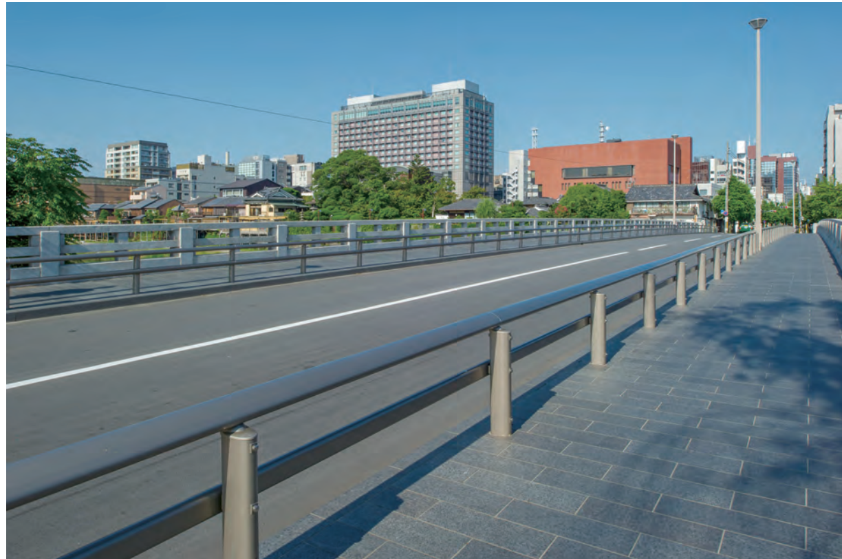
二条大橋／京都府 種別: Bp種 タイプ: アスレール 工事: 改修
