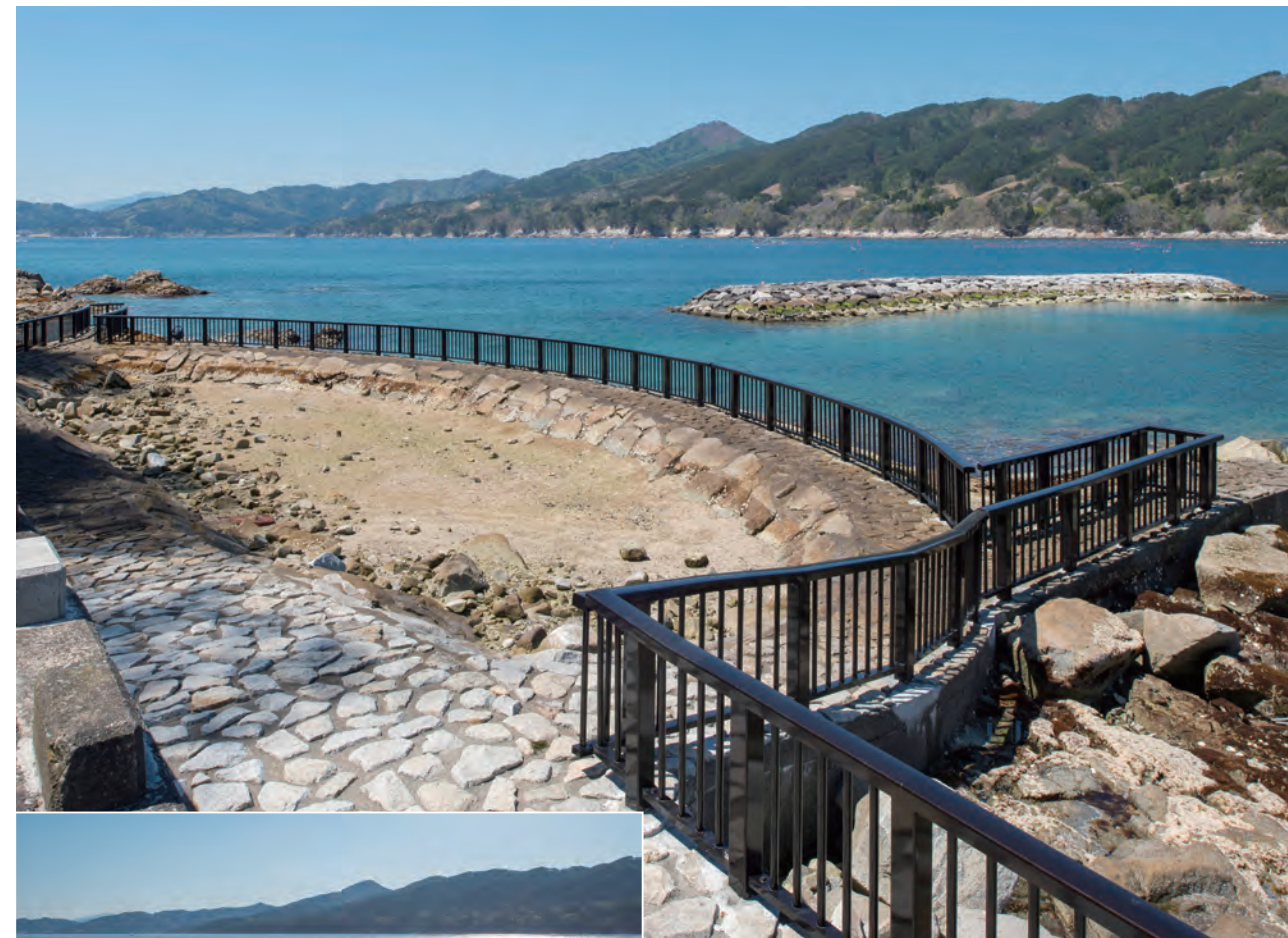
船越漁港しもかわ公園/岩手県 種別:ハイテンション型高欄(耐波浪型) タイプ:アルミ合金製 工事:新設
