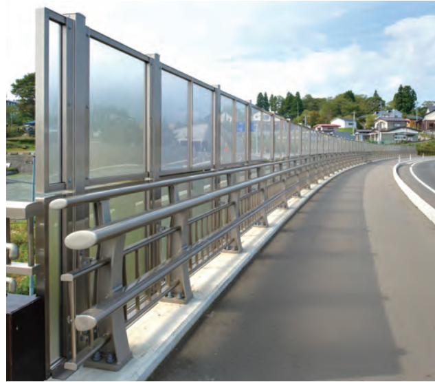
三沢大橋/青森県 種別:A種 タイプ:キャブロー+落下物防止柵(ポリカーボネート板) 工事:新設
