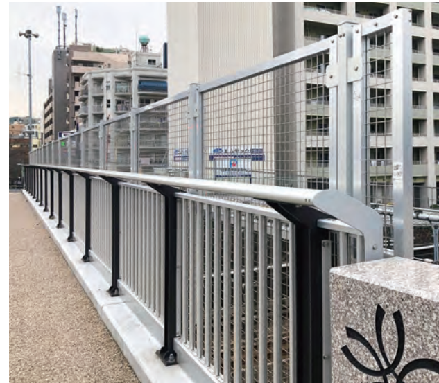
空蝉橋/東京都 種別: SP種 タイプ: アルミ合金製+落下物防止柵 工事: 改修
