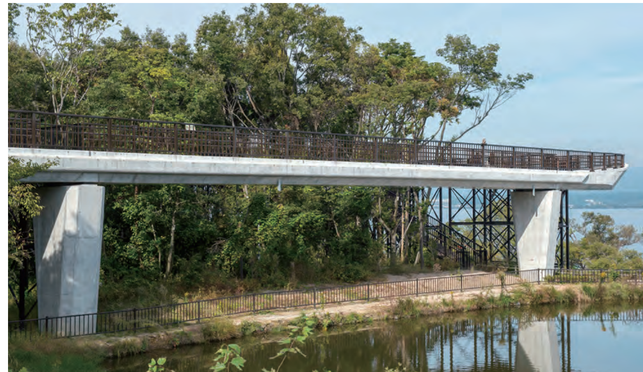
琵琶湖博物館歩道橋 / 滋賀県 種別: SP種 タイプ: アルミ合金製+デザインバラスター+二段手摺 工事: 新設
