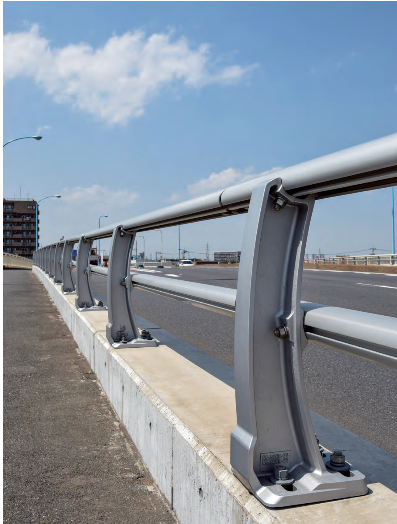
今井橋/東京都 種別: Ap種 タイプ: キャブローア 工事: 改修
