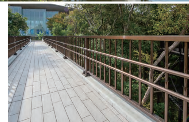
琵琶湖博物館歩道橋 / 滋賀県 種別: SP種 タイプ: アルミ合金製+デザインバラスター+二段手摺 工事: 新設
