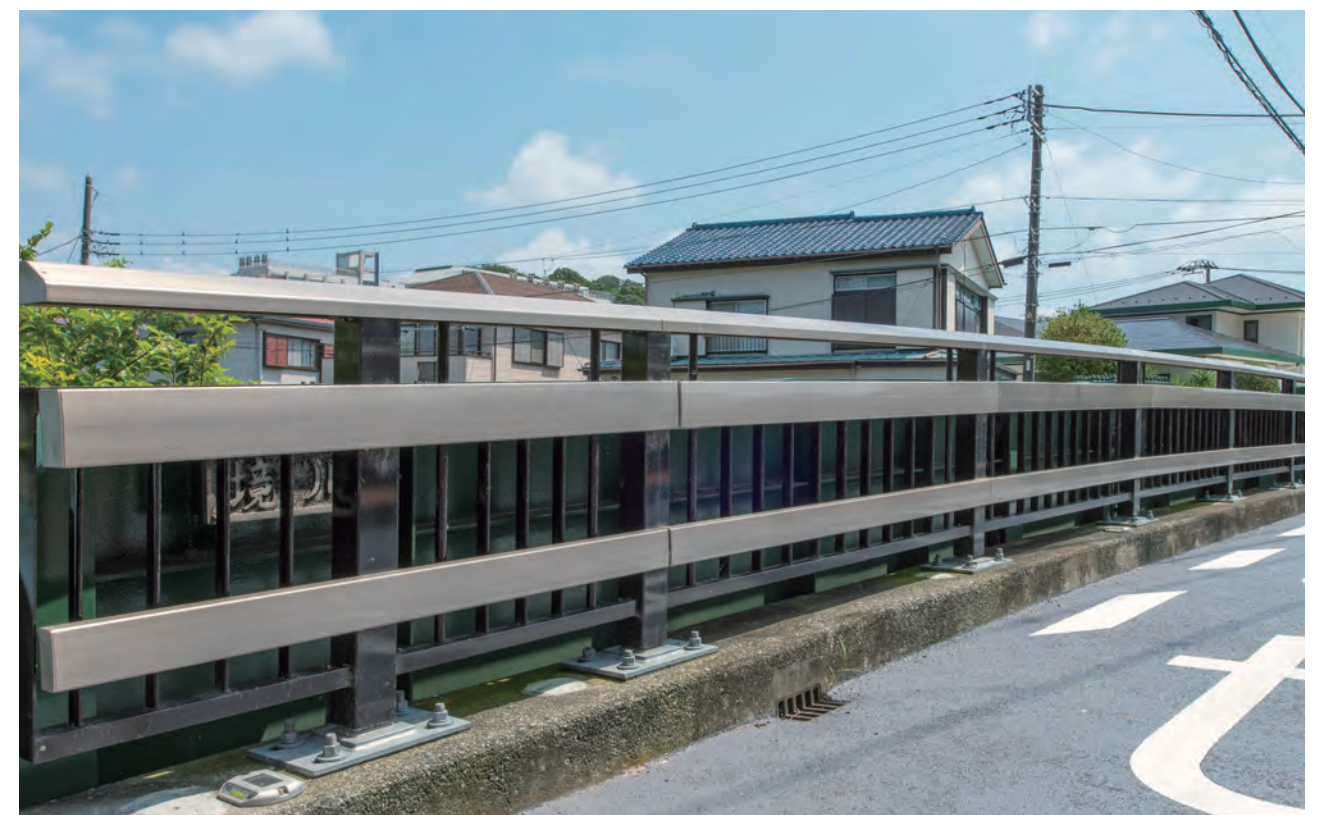
御殿橋/神奈川県 種別: C種 タイプ: アルミ合金製標準(改) 工事: 改修
