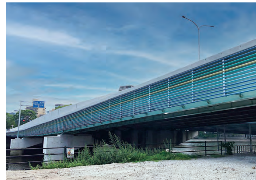
広島駅西高架橋／広島県 桁側面:アルミルーバー 工事:新設
