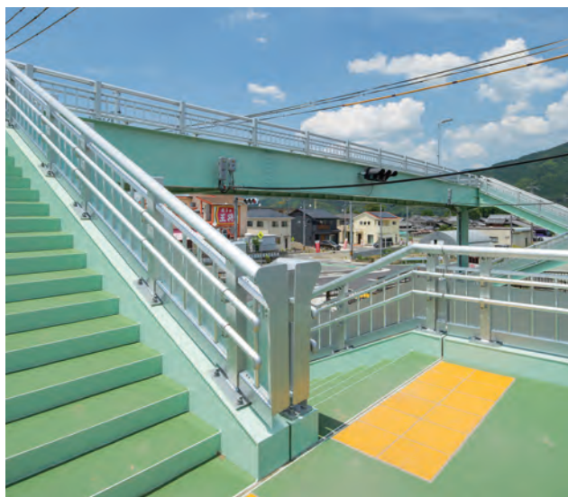
篠横断歩道橋/京都府 種別: SP種 タイプ:アルミ合金製+裾隠し+二段手摺 工事:新設
