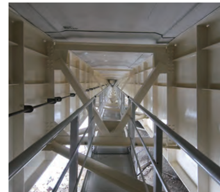
下熊谷川橋/岡山県 上部構造検査路
