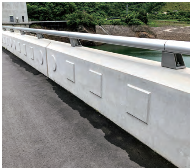
ハツ場ダム天端道路/群馬県 種別:SP種 タイプ:アルミ合金製 工事:新設
