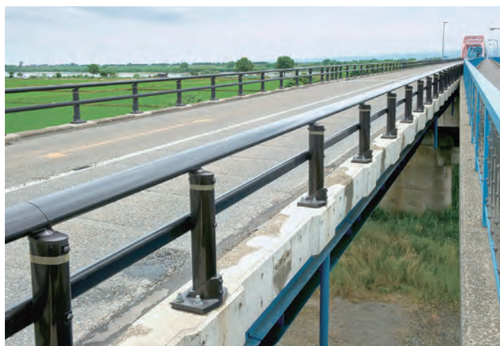
改修後 B種アルミ合金製車両防護柵
