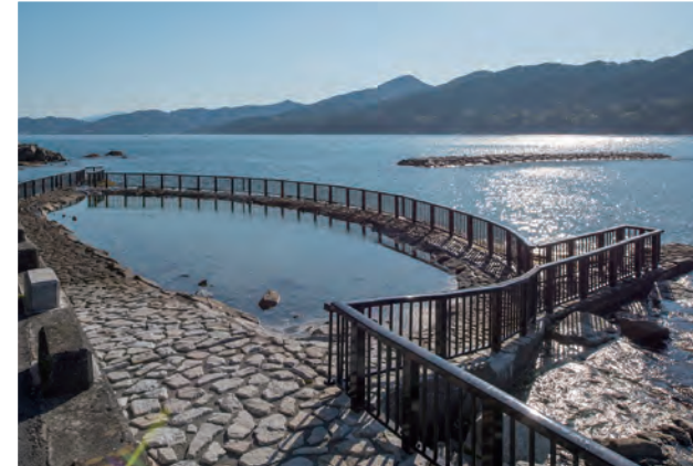
船越漁港しもかわ公園/岩手県 種別:ハイテンション型高欄(耐波浪型) タイプ:アルミ合金製 工事:新設
