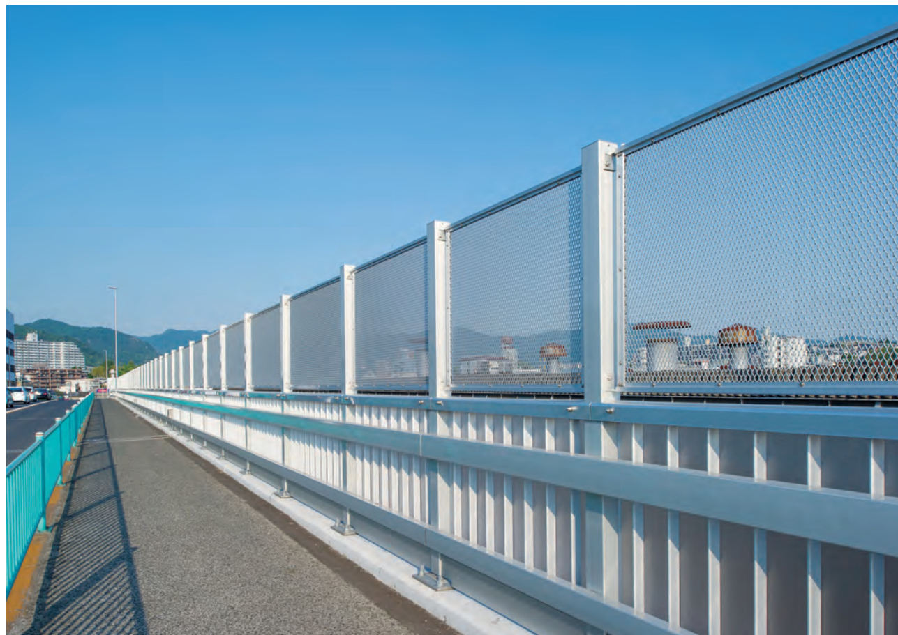
仁保橋/広島県 種別:B種 タイプ:アルミ合金製+落下物防止柵(ラス網) 工事:新設
