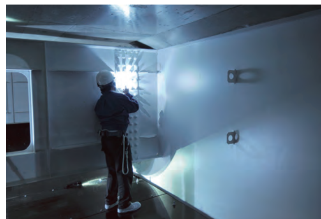
従来のカバー材に比べ突起がなく、滑り止め付のため歩行性が格段に向上。暗い桁の内部でも作業しやすく、面的な点検（近接目視）が可能です。
