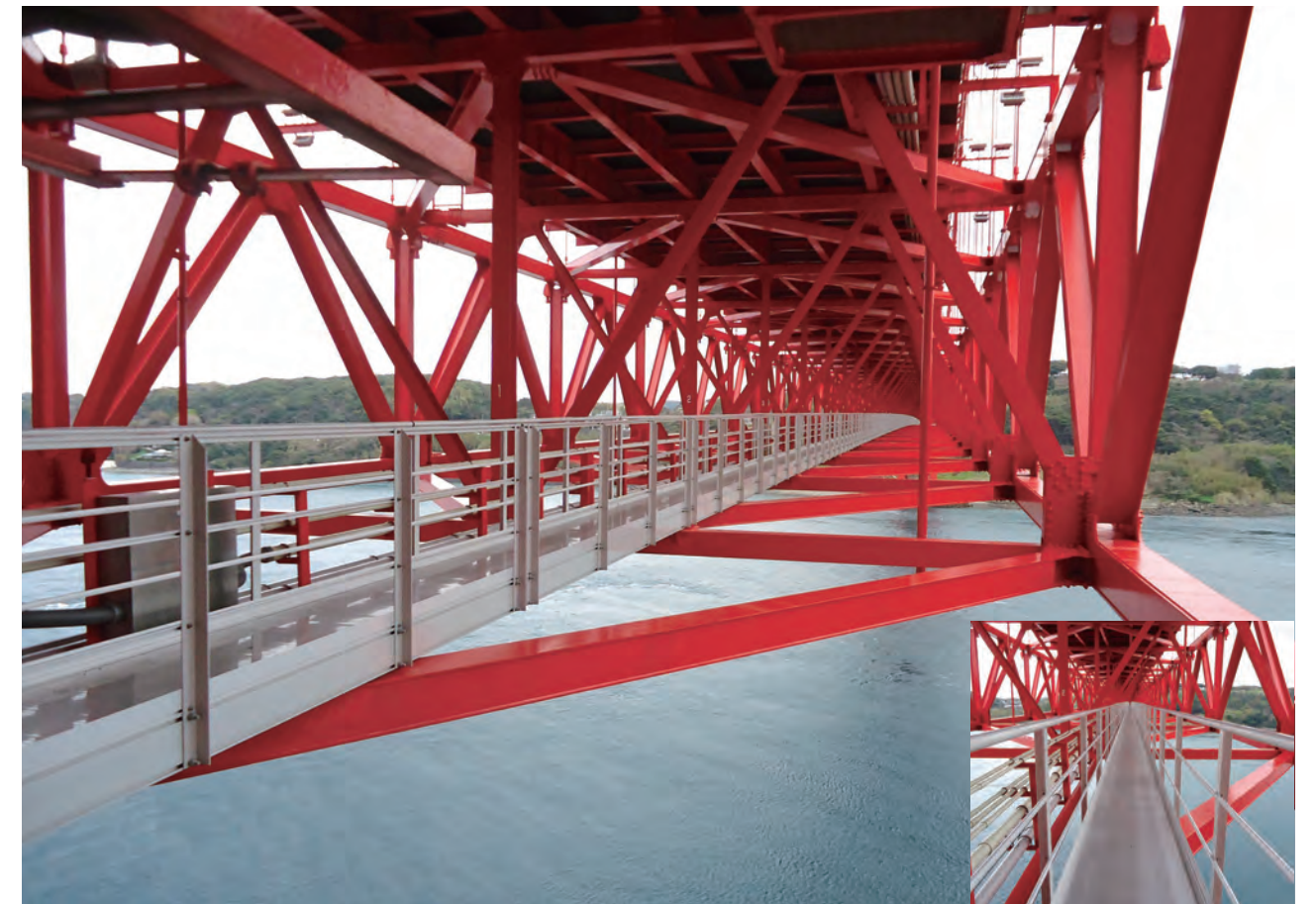
平戸大橋/長崎県 上部構造検査路(取替)
