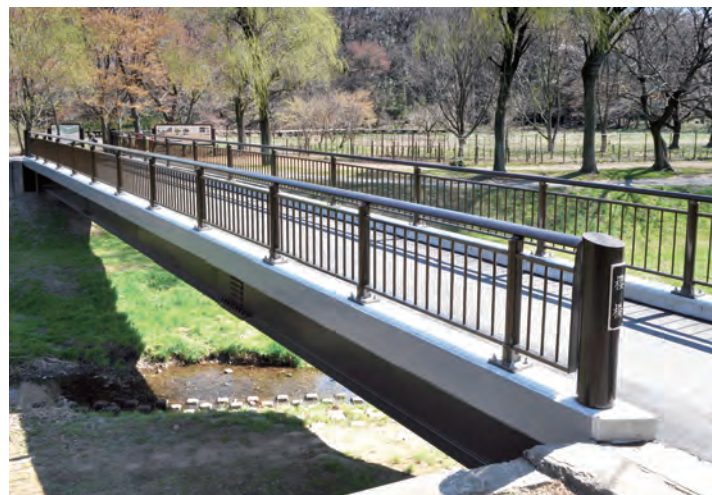
改修後 S P種アルミ合金製高欄
