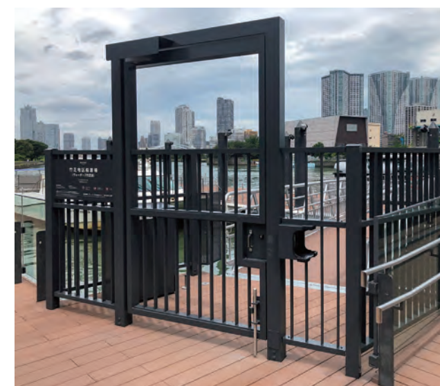
竹芝地区船着場(ウォーターズ竹芝前)/東京都 種別:門扉 タイプ:アルミ合金製 工事:新設
