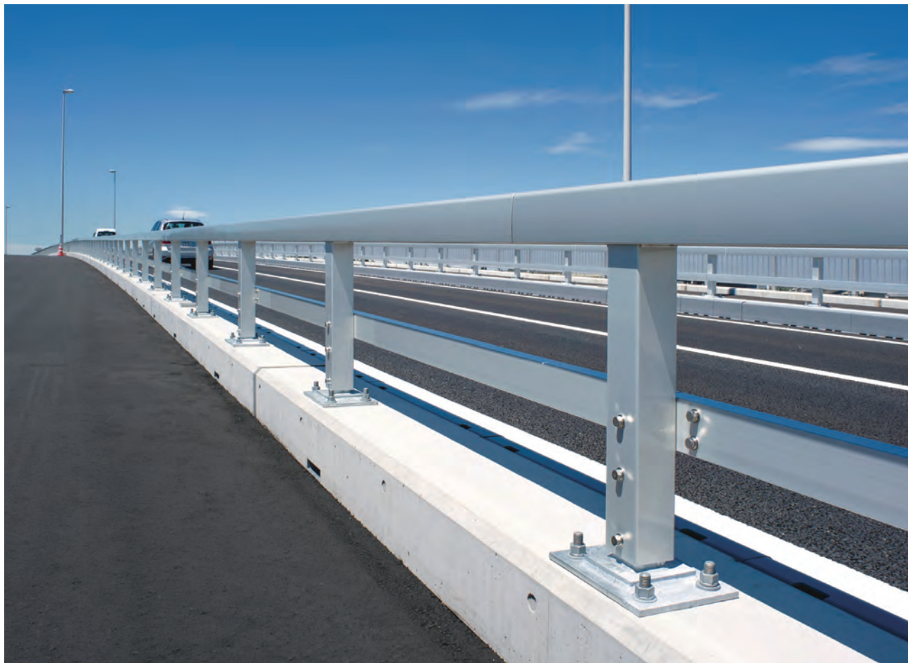
美園駅北陸橋/埼玉県 種別:Bp種 タイプ:アルミ合金製標準 工事:新設
