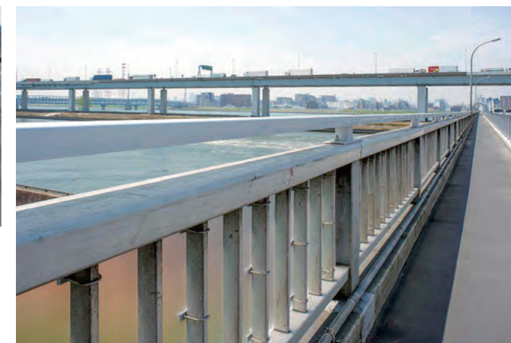
改修後 アルミ合金製高欄に嵩上げ
