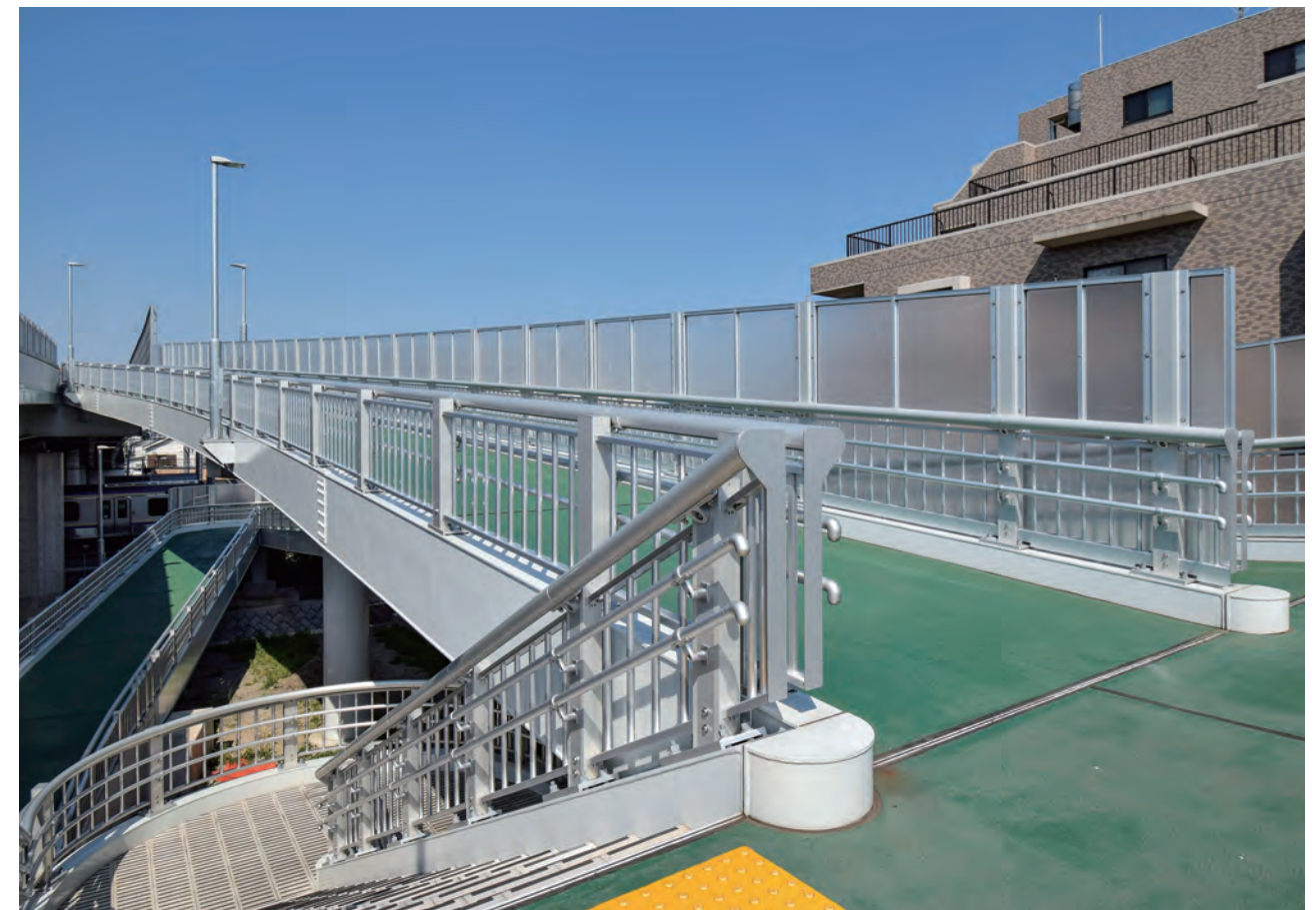
大船立体/神奈川県 種別: SP種 タイプ: アルミ合金製+落下物防止柵+二段手摺 工事: 新設
