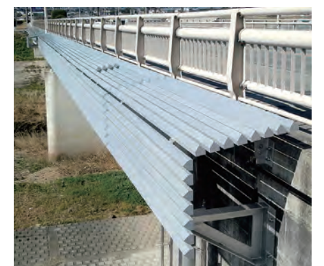
濁川橋／山梨県 添架管カバー:アルミルーバー 工事:新設
