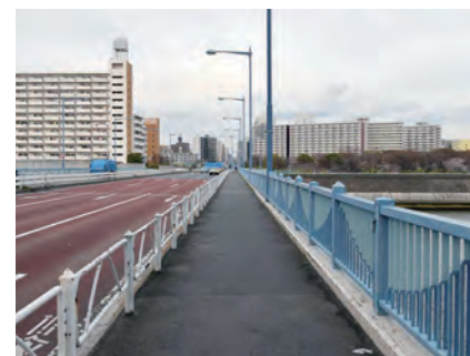
改修前 アルミ合金製高欄
