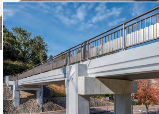
海の森大橋/東京都 種別: SP種 タイプ:アルミ合金製+侵入防止+二段手摺 工事:新設
