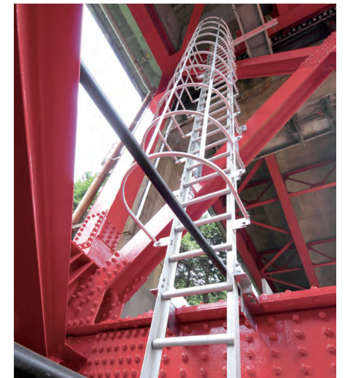
中国自動車道 千種川橋/兵庫県 ケーロ梯子
