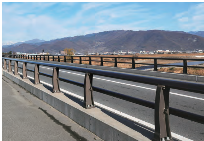
改修後 Cp種アルミ合金製車両防護柵
