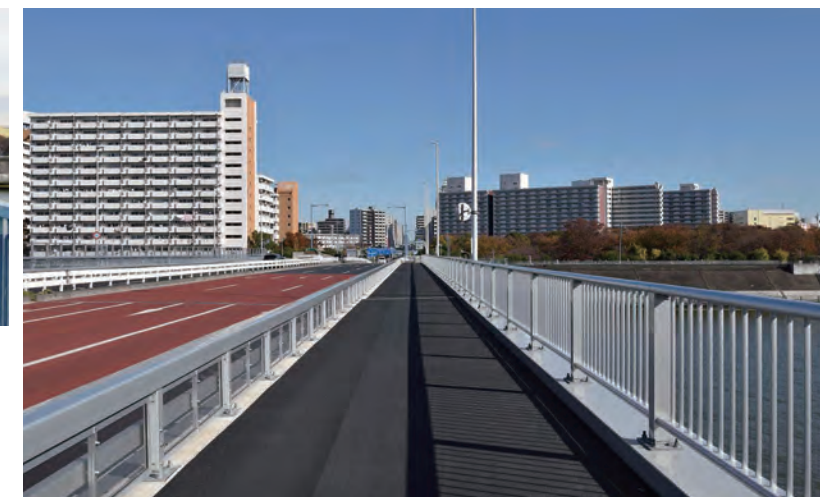
改修後 A種歩車道境界用車両防護柵
