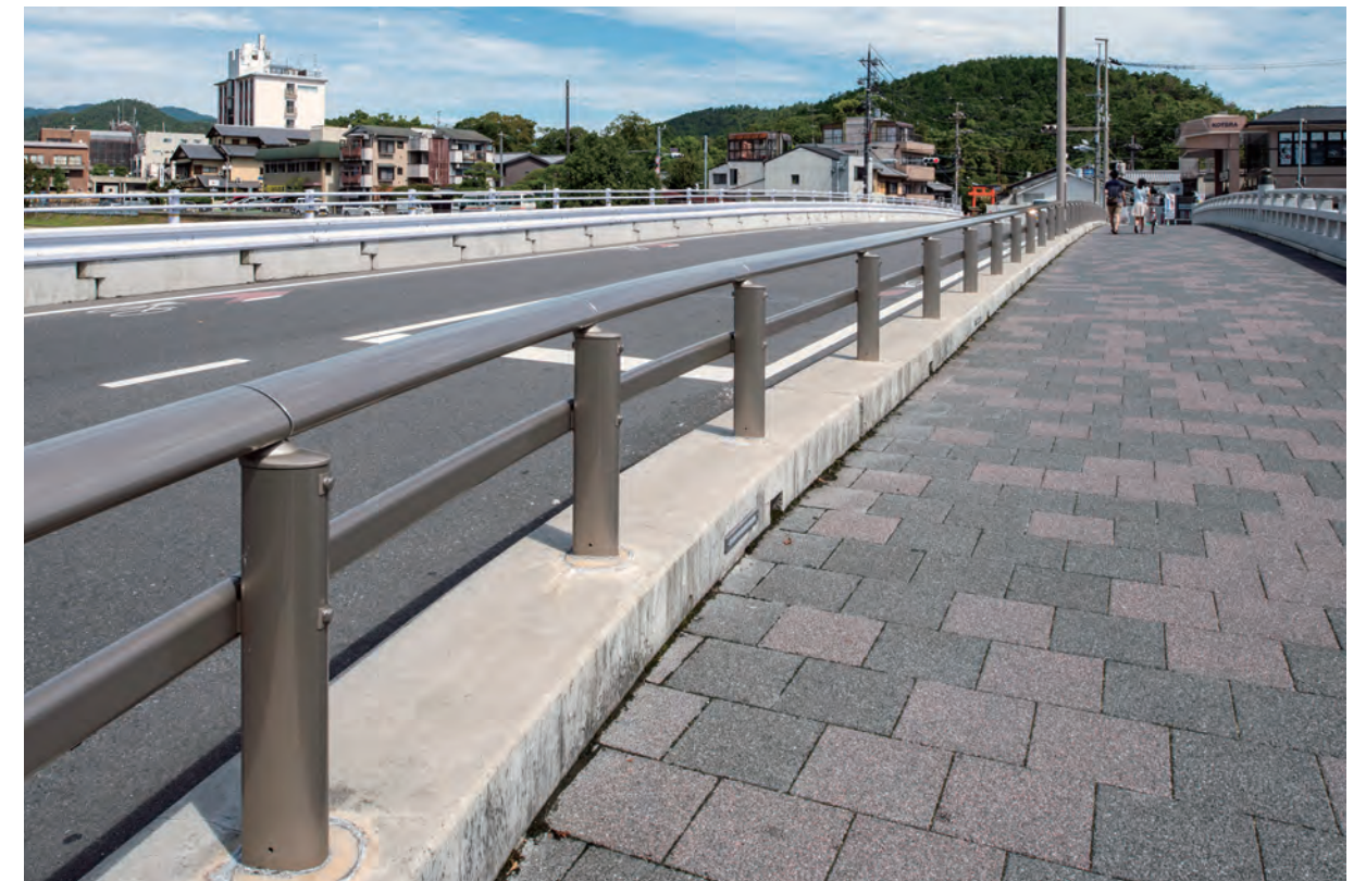
御園橋／京都府 種別: Bp種 タイプ: アスレール 工事: 改修
