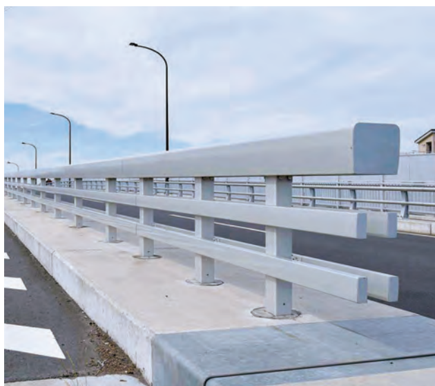
国分寺陸橋/東京都 種別:Am種 タイプ:アルミ合金製標準 工事:新設
