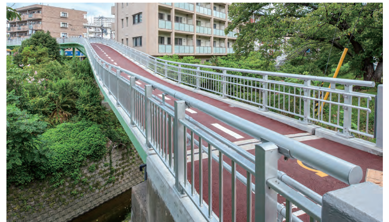
上天竺橋/大阪府 種別: SP種 タイプ: アルミ合金製+二段手摺 工事: 新設
