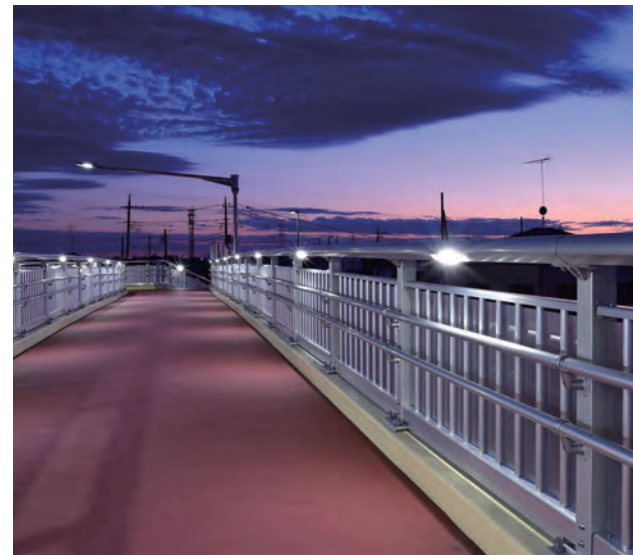
佐間歩道橋/埼玉県 種別: SP種 タイプ: アルミ合金製+LED照明内蔵+二段手摺 工事: 新設
