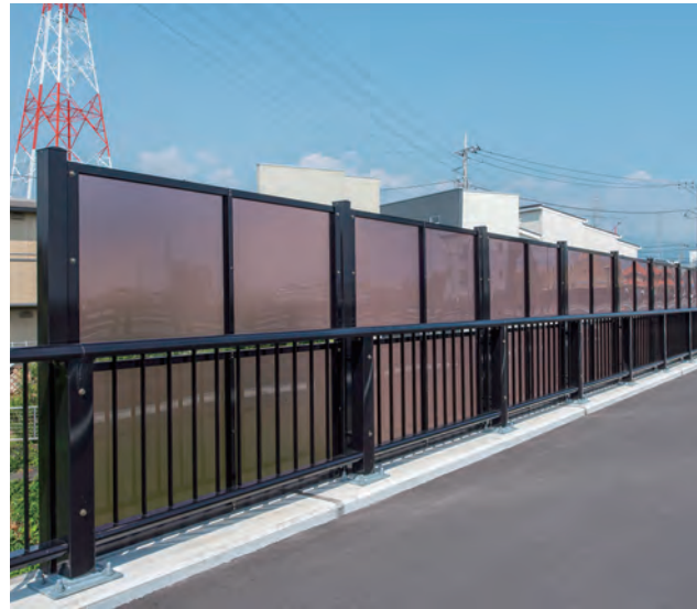
鏡ヶ淵大橋/静岡県 種別: SP種 タイプ: アルミ合金製+落下物防止柵 工事: 新設
