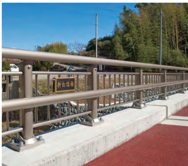
新白塩橋／群馬県 種別:C種 タイプ:アスレール 工事:新設
