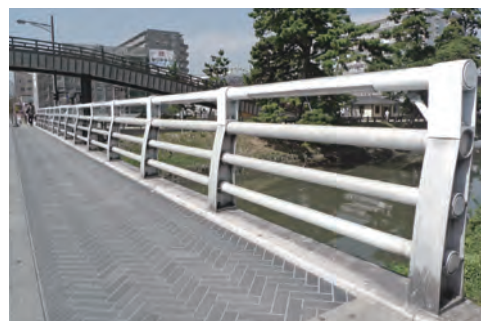
改修前 アルミ合金製嵩上げ高欄
