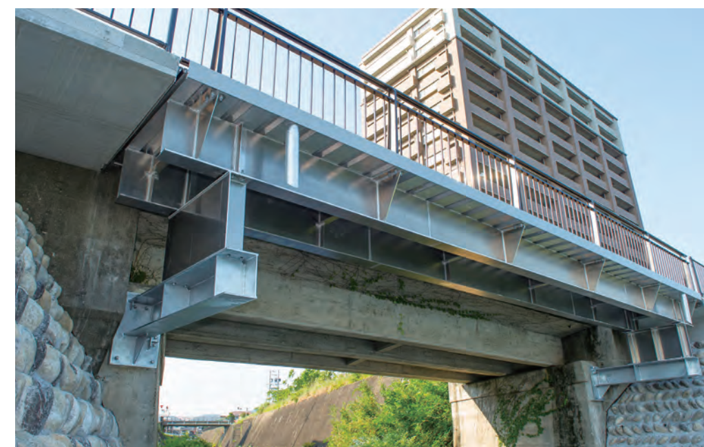
城見橋／岐阜県 コンパクトブリッジ・高欄:SP種キャプロア
