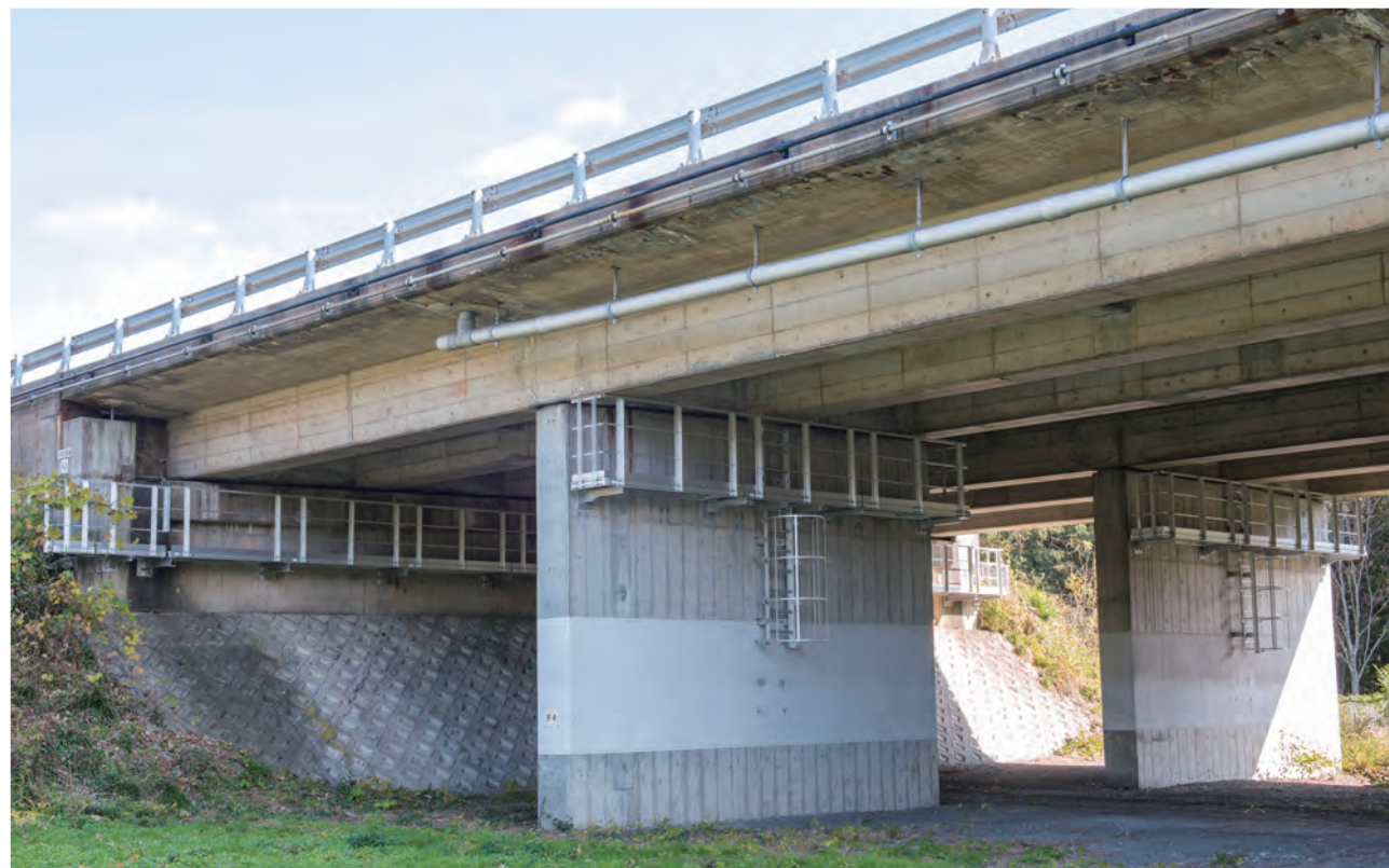
名神林田第二高架橋/滋賀県 下部構造検査路
