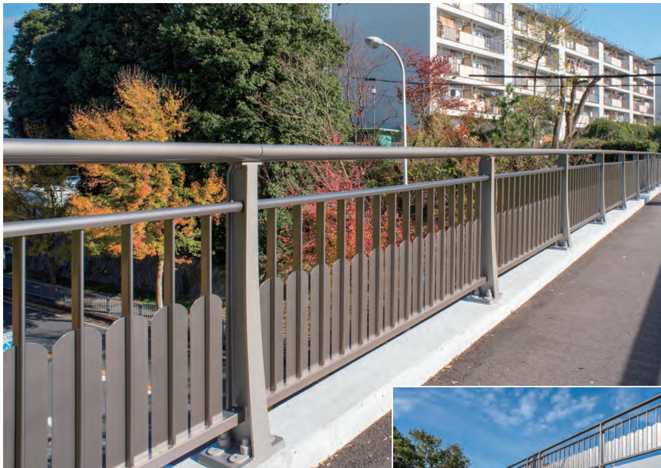
ざいふり橋補修/大阪府 種別: SP種 タイプ:キャブロー+裾隠し 工事:新設
