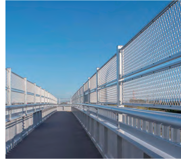
太平尾歩道橋/三重県 種別: SP種 タイプ: アルミ合金製+落下物防止柵+二段手摺 工事: 新設
