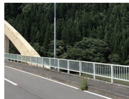
改修前 鋼製高欄
