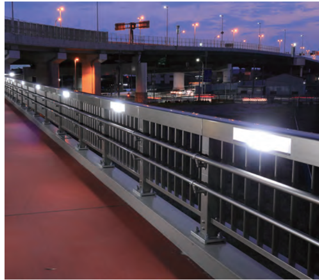
新大塚歩道橋/大阪府 種別: SP種 タイプ: アルミ合金製+LED照明内蔵 工事: 新設
