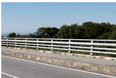
改修前 鋼製高欄兼用車両防護柵
