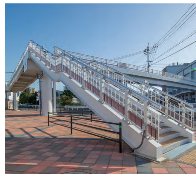
碩田歩道橋/大分県 種別: SP種 タイプ:アルミ合金製+裾隠し+二段手摺 工事:新設
