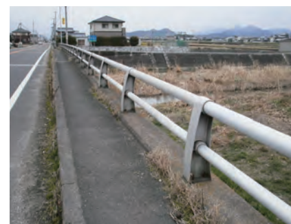
改修前 アルミ合金製高欄
