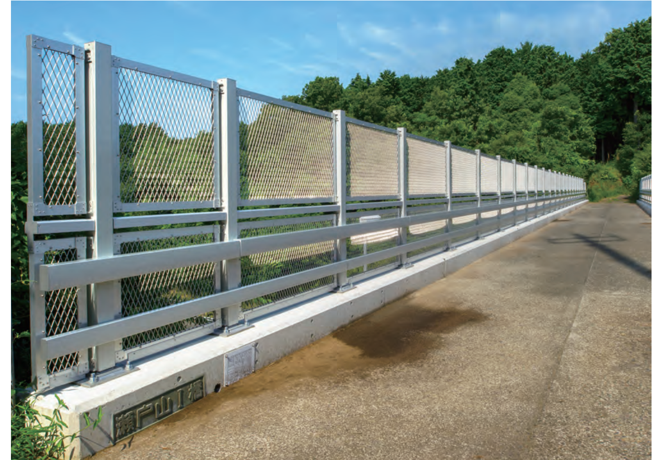
瀬戸山I橋/静岡県 種別:C種 タイプ:アルミ合金製+落下物防止柵(ラス網) 工事:改修
