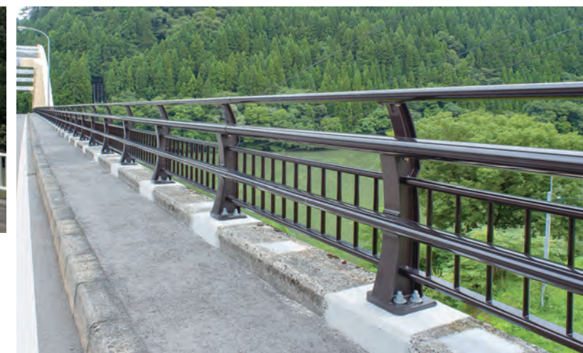
改修後 B種アルミ合金製高欄兼用車両防護柵
