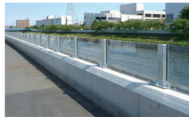
新河岸川高上げ/東京都 種別:アクリル止水壁 工事:新設
