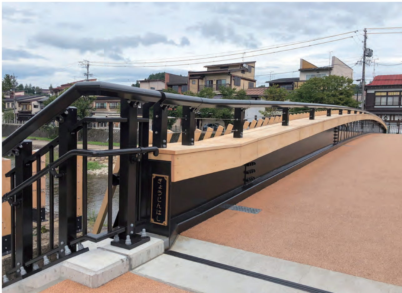
行神橋/岐阜県 種別:SP種 タイプ:アルミ合金製(カバー材別途) 工事:新設
