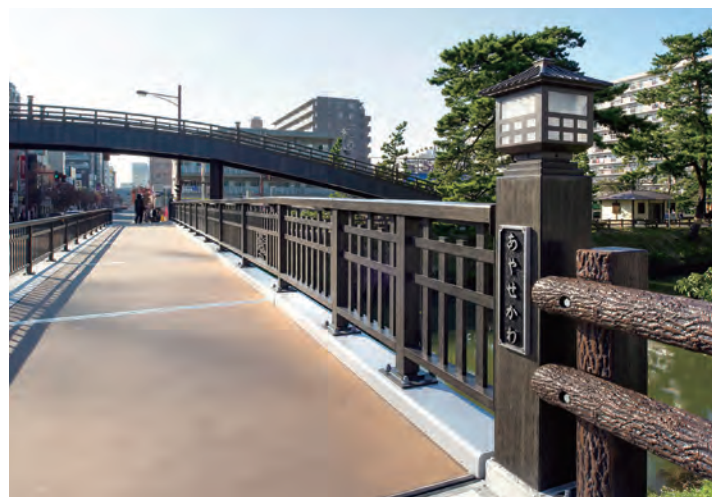
改修後 S P種アルミ合金製ハイテンション型高欄
