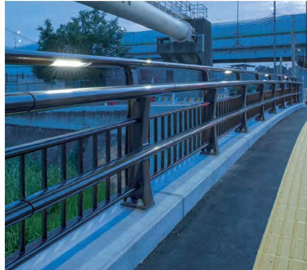
宝来橋/埼玉県 種別:C種 タイプ:キャブロー+LED照明内蔵 工事:新設
