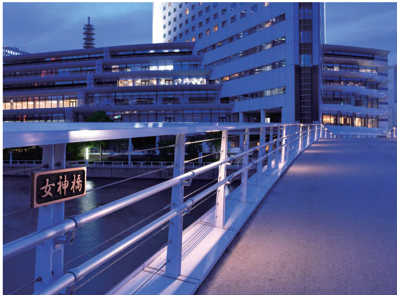
女神橋/神奈川県 種別: SP種 タイプ: アルミ合金製+鋼製+LED照明内蔵+二段手摺 工事: 新設
