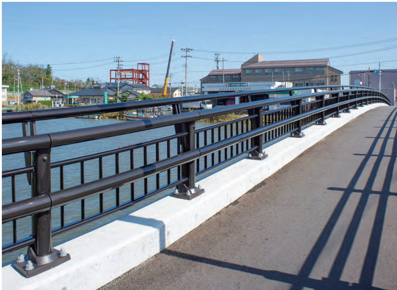
松港橋／新潟県 種別:B種 タイプ:アスレール 工事:改修
