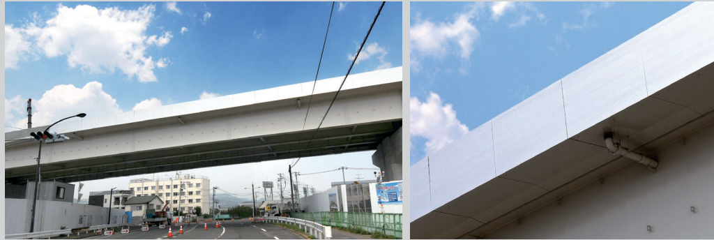
高速3号線Ⅲ期鋼上部工(観音西 工区)型枠:広島県
