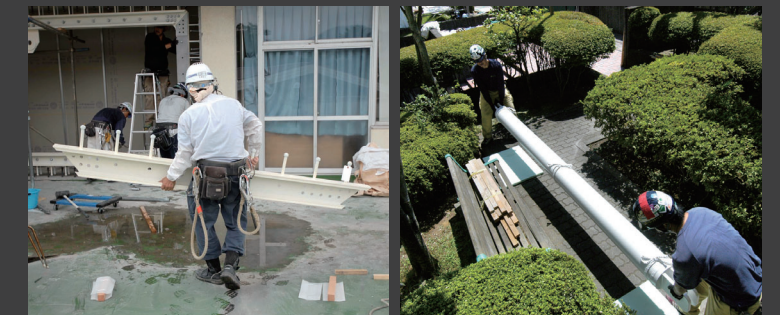
軽さを活かした施工事例 アルミ合金製耐震プレースの場合
