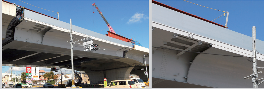
街路工事徳島東環状未広・住吉 高架橋:徳島県
