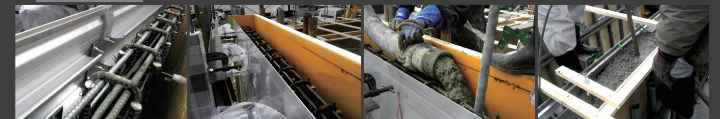
●残存型枠と配筋の状況
