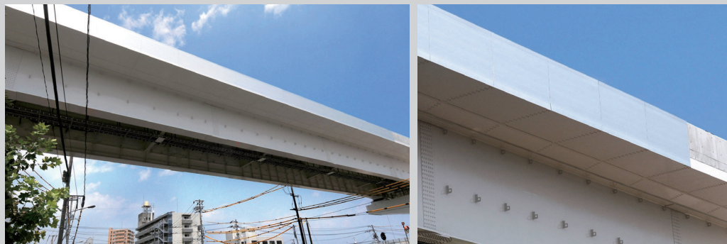
高速3号線Ⅲ期鋼上部工(江波東 P127-133)型枠:広島県
