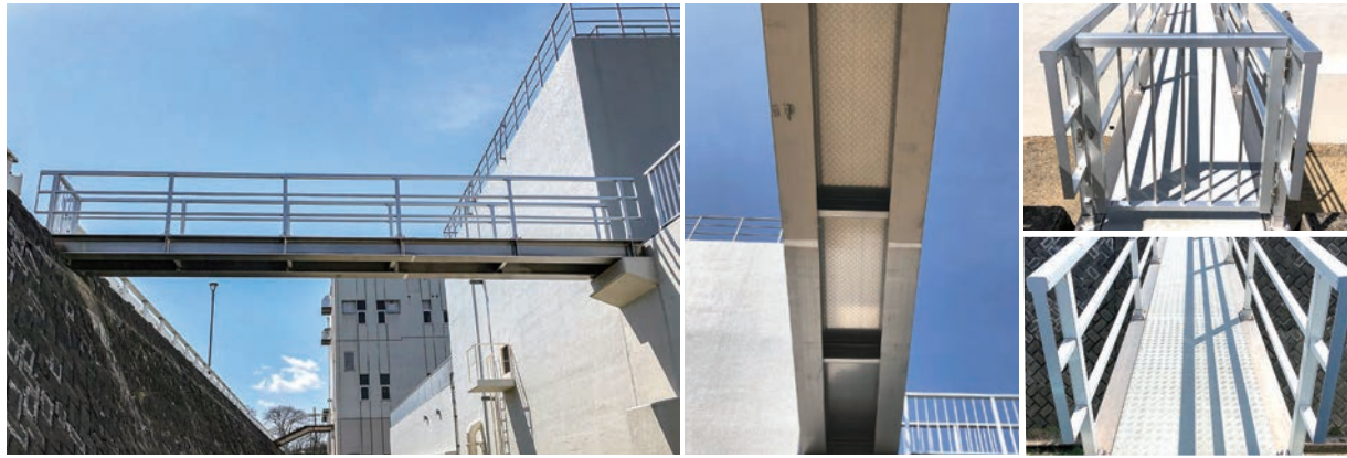
管理路歩廊 歩廊床版 上/管理路門扉 下/歩廊内観
