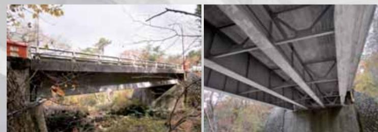
「金慶橋」は、1961年(昭和36年)6月に本邦初の全溶接アルミニウム橋梁として、芦屋一有馬間有料道路に架橋されました。橋桁部は、アルミニウム合金の高耐食性が発揮され、健全な状態が維持されています。
