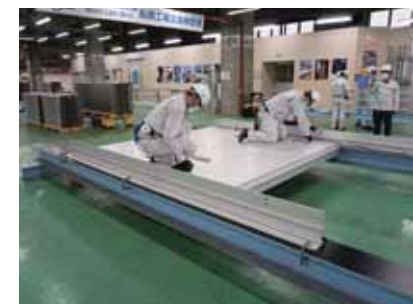
設置 (ボルト締め付け)
