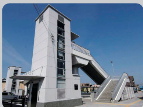
エレベーター棟外装
