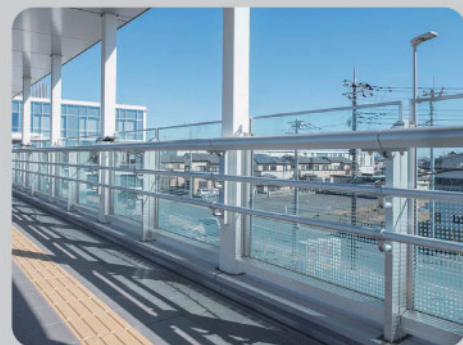
転落防止柵（高欄）
