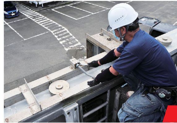
▲電動装置の動作確認およびボルトゆるみ確認
