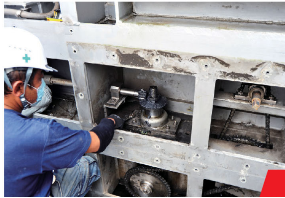
▲可動部のオイル補填及びボルトゆるみ確認
