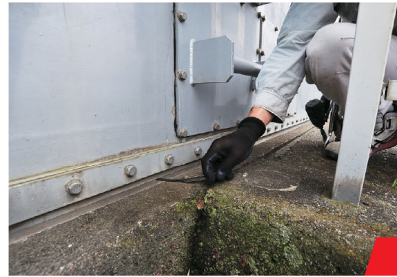
▲電動動作確認と水密ゴムのつぶれ確認
