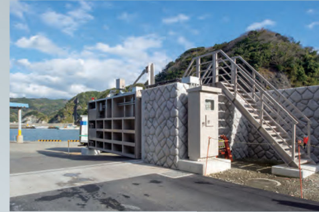
妻良4号（妻良漁港陸閘）静岡県
