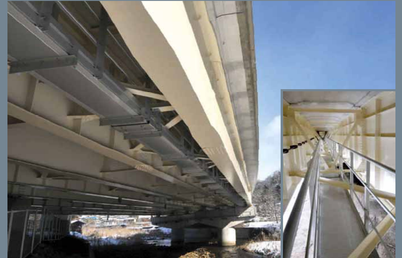
件名：下熊谷橋 施主：西日本高速道路株式会社 場所：岡山県新見市
