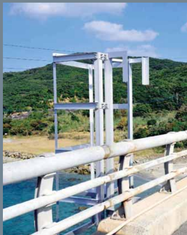
件名：頭ヶ島大橋 施主：五島振興局上五島支所 場所：長崎県南松浦郡
