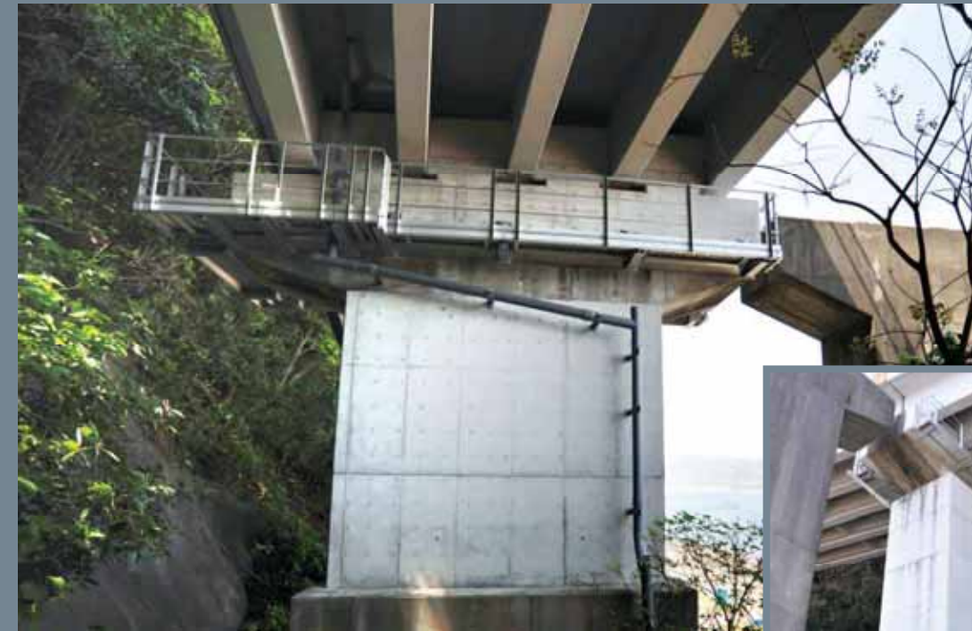
件名：汐吹高架橋検査路 施主：静岡県熱海土木事務所伊東支所 場所：静岡県伊東市
