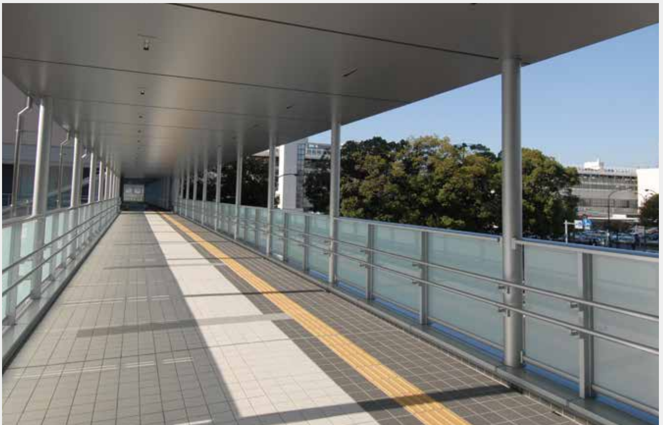
■ 常盤橋若草線横断歩道橋 広島県
