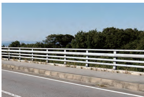
改修前 鋼製高欄兼用車両防護柵
