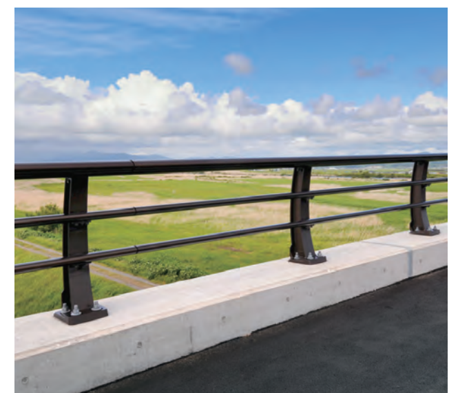
第二津軽大橋／青森県 種別: B種 タイプ: キャブローア 工事: 新設
