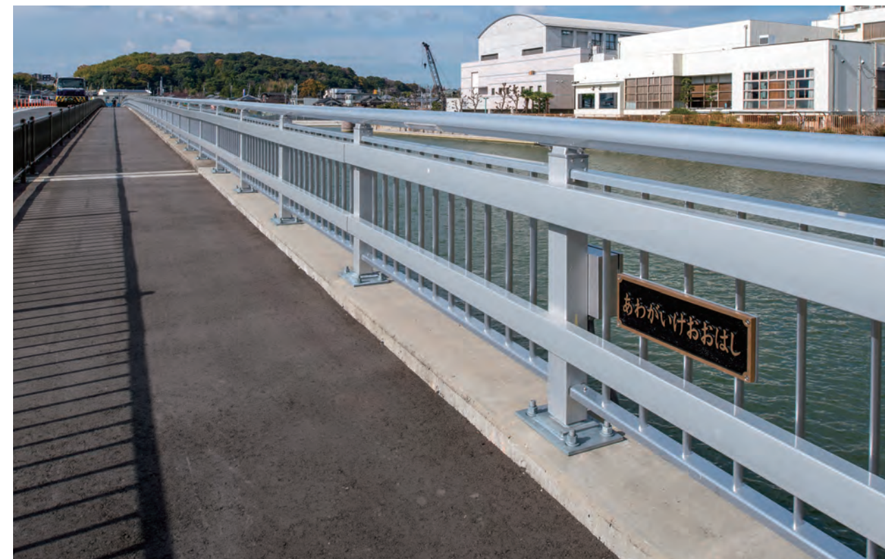
粟ヶ池大橋／大阪府 種別: B種 タイプ: アルミ合金製標準(改) 工事: 改修
