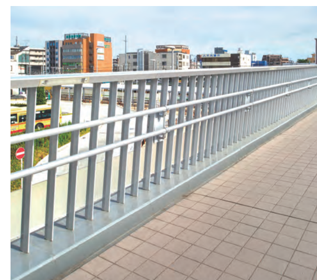
長津田駅北口歩行者専用通路／神奈川県 種別:SP種 タイプ:アルミ合金製+LED照明内蔵 工事:新設
