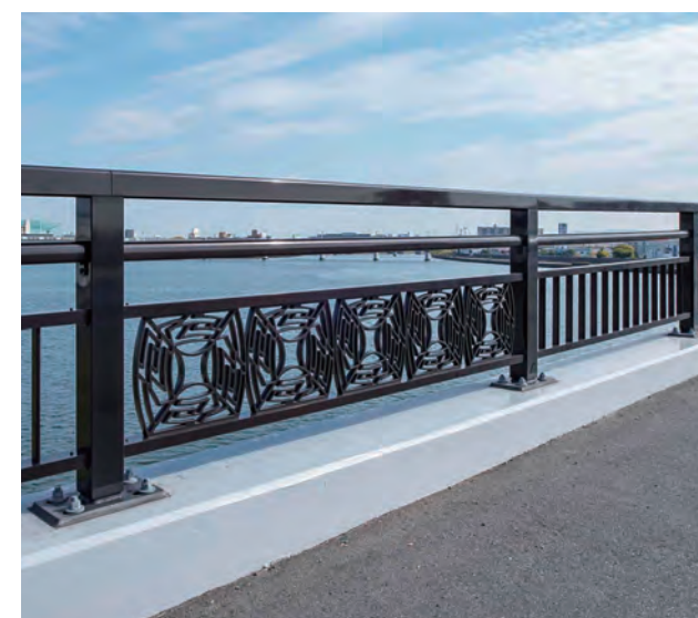
神崎橋／大阪府 種別:SP種 タイプ:アルミ合金製+鋳物パネル 工事:改修
