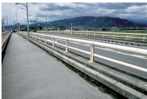
改修前 鋼製防護柵
