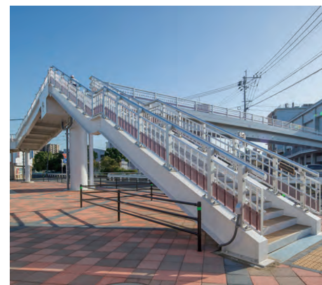
碩田歩道橋/大分県 種別: SP種 タイプ: アルミ合金製+裾隠し+二段手摺 工事: 新設
