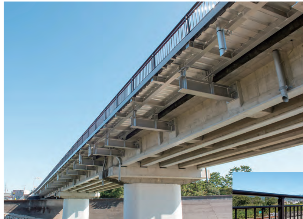
新志原橋拡幅／三重県 アルミ歩道拡幅床版(PC橋ブラケット方式)・ 高欄:アルミ合金製SP種
