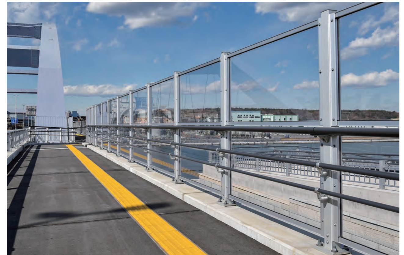
海の森大橋／東京都 種別: SP種 タイプ: アルミ合金製+落下物防止柵+二段手摺 工事: 新設
