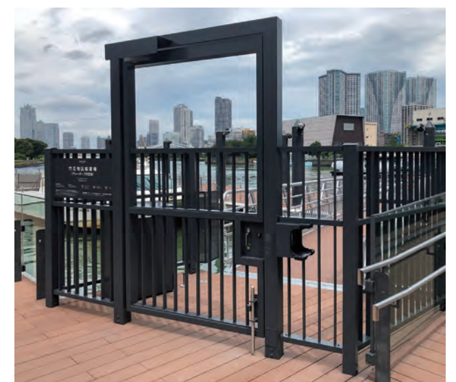
竹芝地区船着場(ウォーターズ竹芝前)／東京都 種別:門扉 タイプ:アルミ合金製 工事:新設
