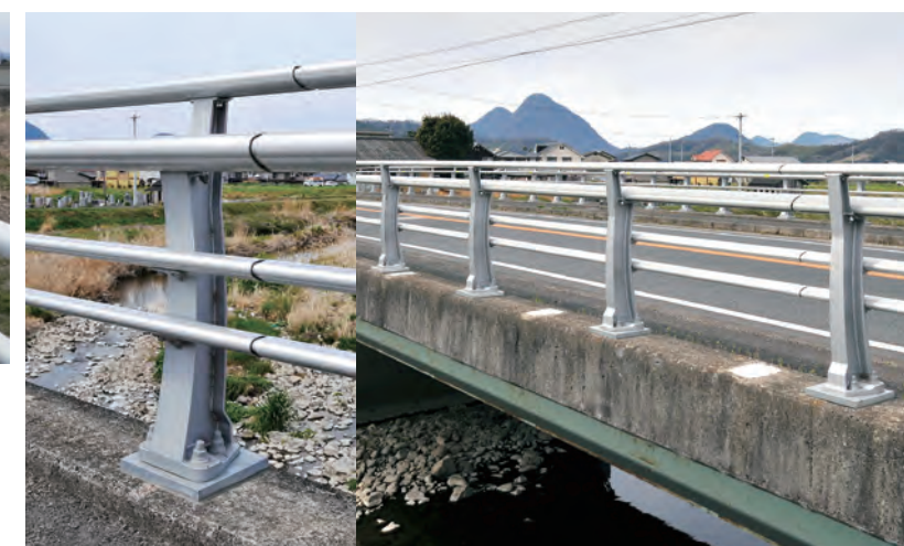
改修後 C種アルミ合金製車両用防護柵
