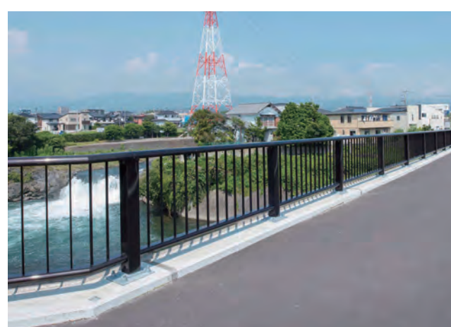
鎧ヶ淵大橋／静岡県 種別:ハイテンション型高欄 タイプ:アルミ合金製・標準 工事:新設
