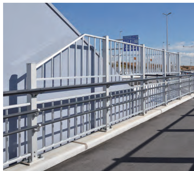
海の森大橋/東京都 種別: SP種 タイプ: アルミ合金製+侵入防止+二段手摺 工事: 新設
