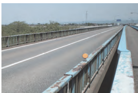
改修前 鋼製高欄
