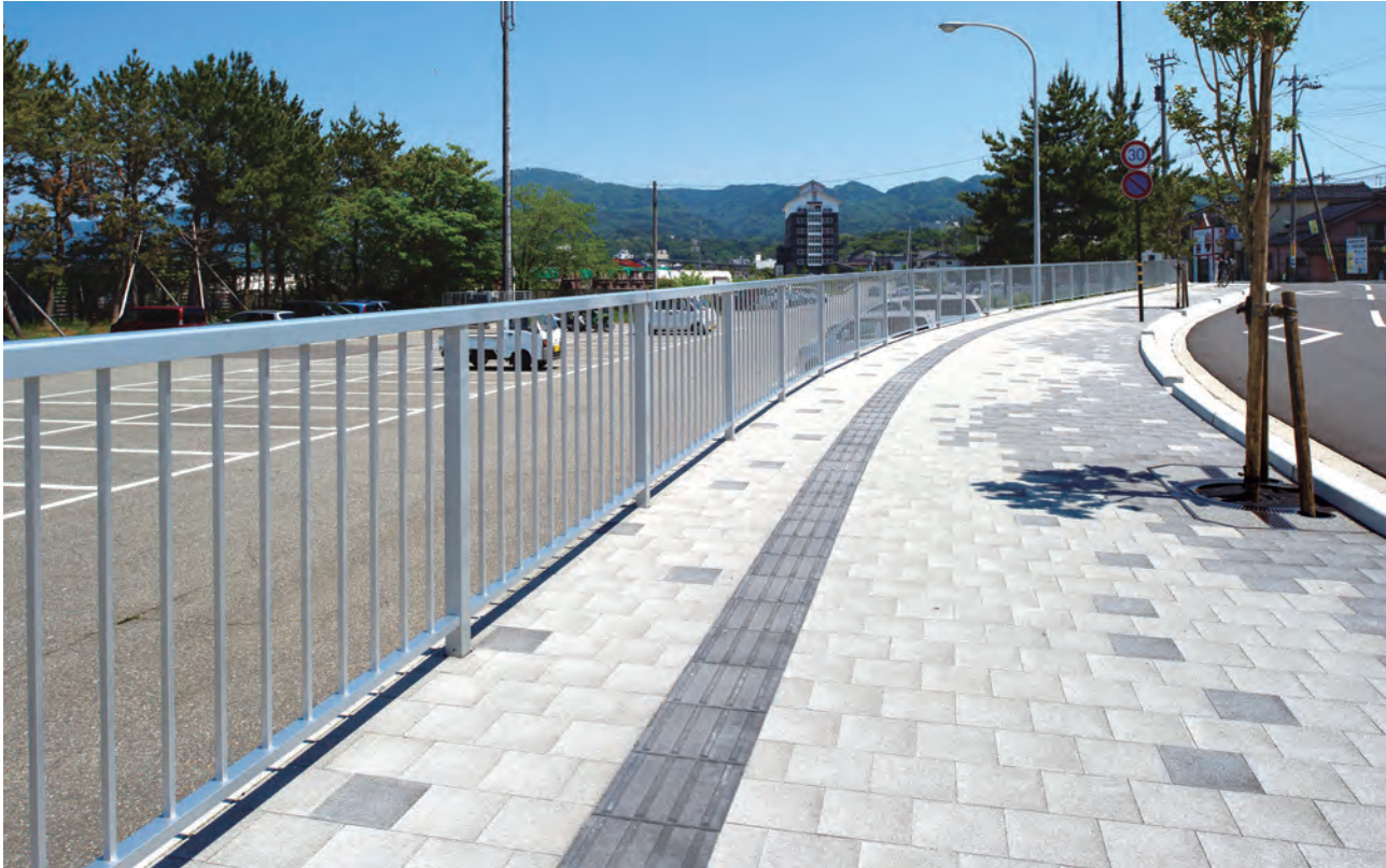
輪島市道みなと線 転落防止柵／石川県 種別: P種 タイプ: アルミ合金製標準 工事: 新設
