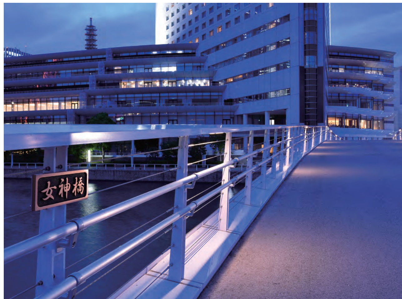
女神橋／神奈川県 種別: SP種 タイプ:アルミ合金製+銅製+LED照明内蔵+二段手摺 工事:新設
