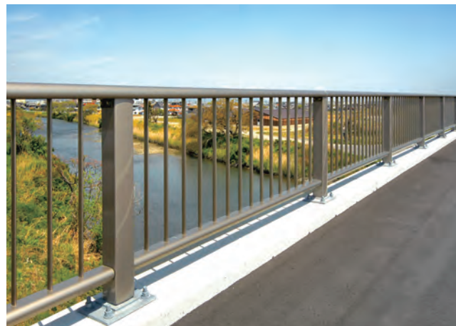
古川大橋／静岡県 種別:ハイテンション型高欄 タイプ:アルミ合金製・標準 工事:新設
