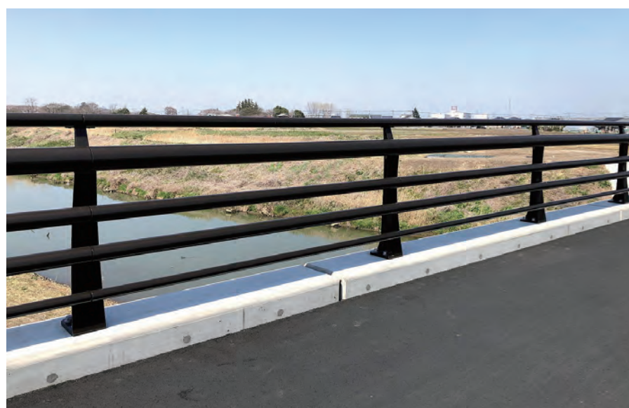
令和橋／埼玉県 種別: B種 タイプ: モデスト 工事: 新設
