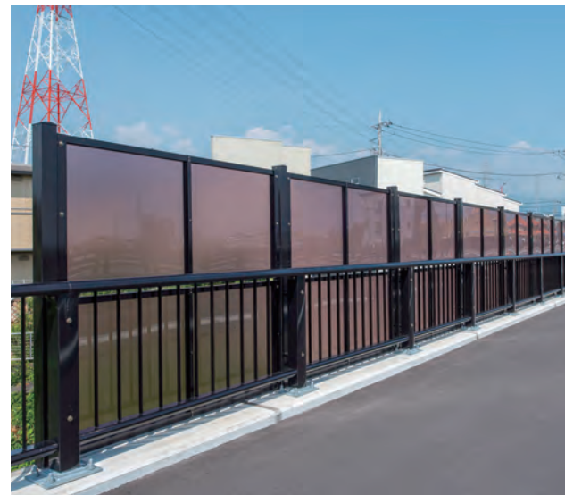
鎧ヶ淵大橋／静岡県 種別: SP種 タイプ: アルミ合金製+落下物防止柵 工事: 新設
