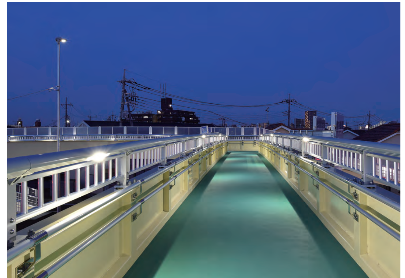
鶴塚歩道橋／埼玉県 種別: SP種 タイプ:アルミ合金製+LED照明内蔵 工事:新設
