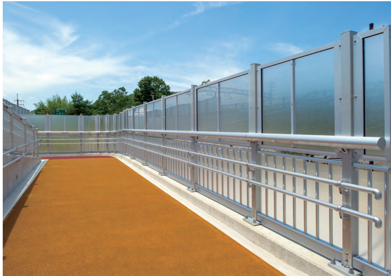
長慶橋／京都府 種別: SP種 タイプ: アルミ合金製+落下物防止柵+二段手摺 工事: 新設
