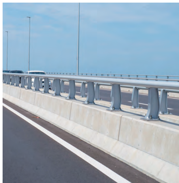
カーミージー橋／沖縄県 種別: SB種 タイプ: アルミ合金製 工事: 新設
