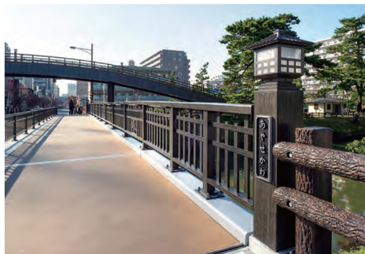
改修後 S P 種アルミ合金製ハイトテンション型高欄
