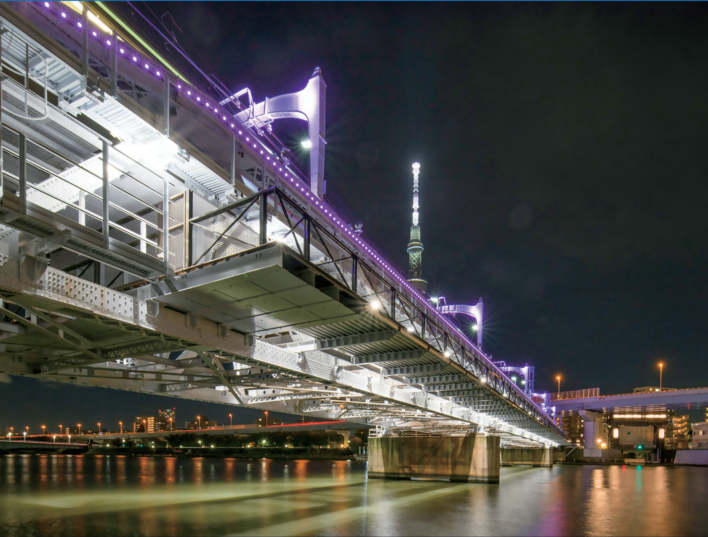
すみだリバーウォーク／東京都（アルミ歩道拡幅床版・アルミ製転落防止柵・検査路）
