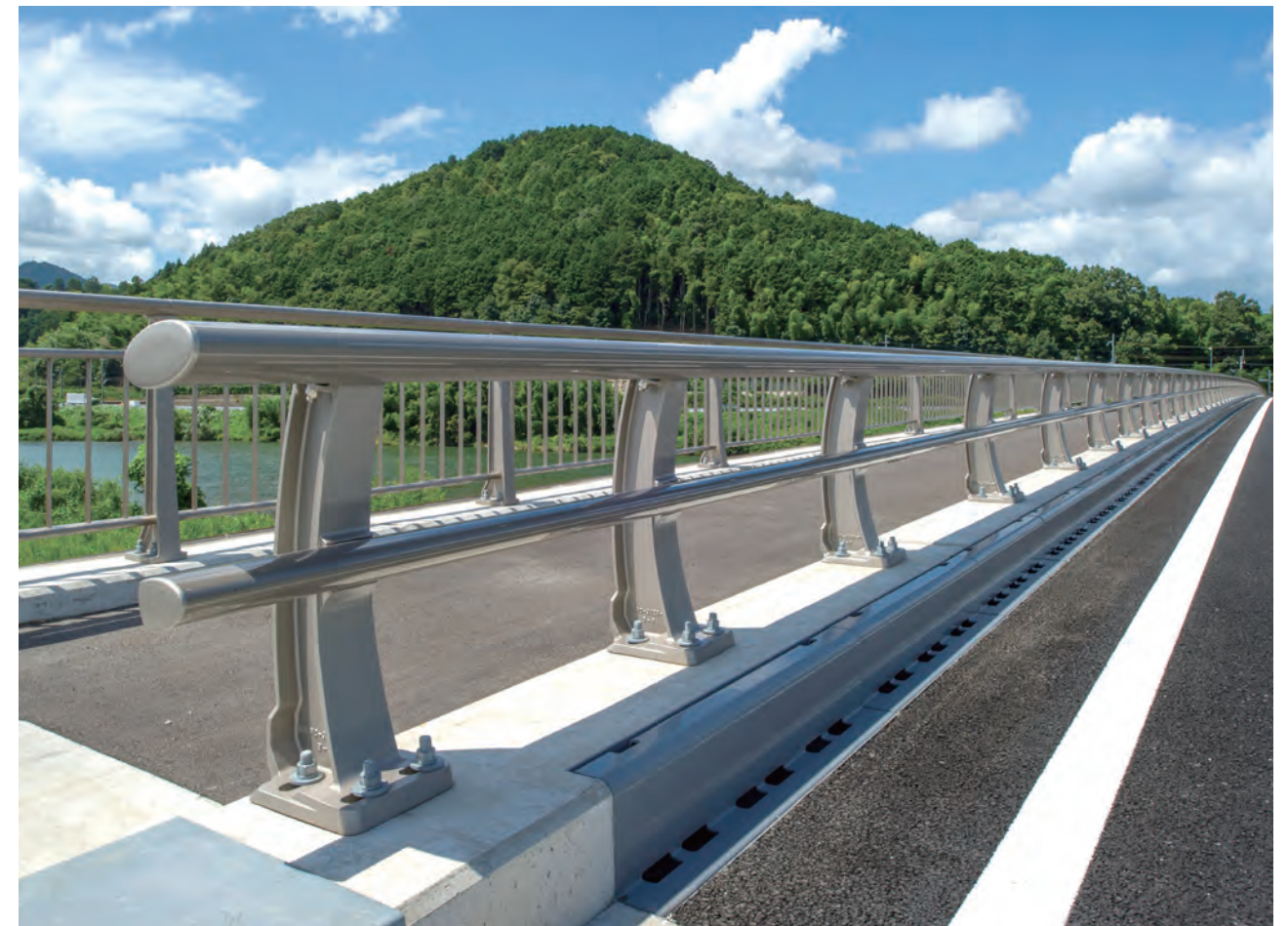
高畑橋／京都府 種別: Cp種 タイプ: キャブローア 工事: 新設
