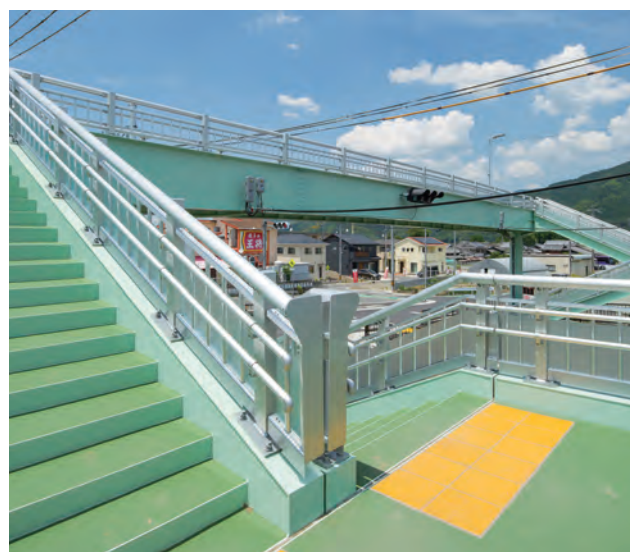
篠横断歩道橋/京都府 種別: SP種 タイプ: アルミ合金製+裾隠し+二段手摺 工事: 新設
