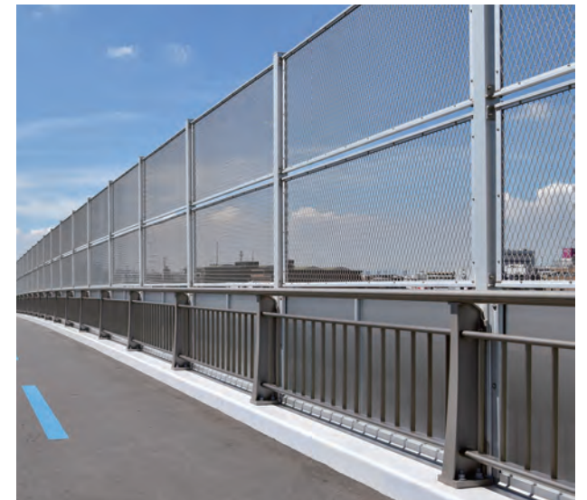
妙典橋／千葉県 種別: SP種 タイプ: キャブローア+落下物防止柵 工事: 新設
