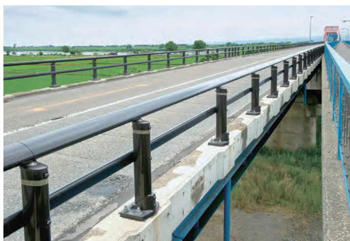
改修後 B種アルミ合金製車両用防護柵
