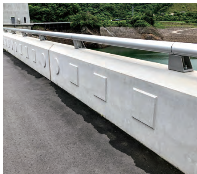
ハッ場ダム天端道路／群馬県 種別:SP種 タイプ:アルミ合金製 工事:新設
