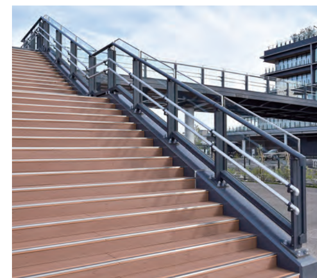
横浜ハンマーヘッドデッキ/神奈川県 種別: SP種 タイプ: GPAL+二段手摺 工事: 新設
