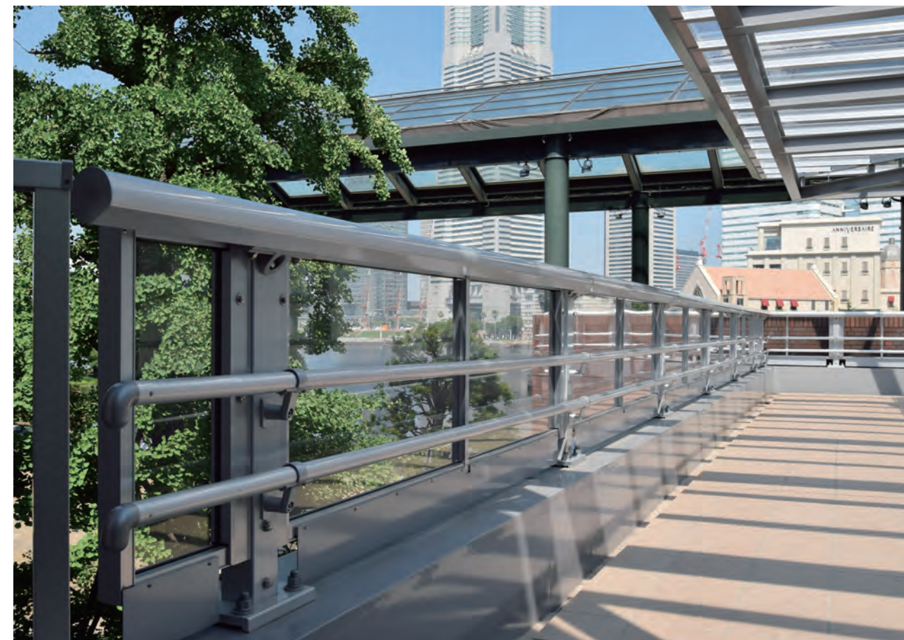
横浜エアキャビン新港地区連絡通路/神奈川県 種別: SP種 タイプ: アルミ合金製+二段手すり 工事: 新設
