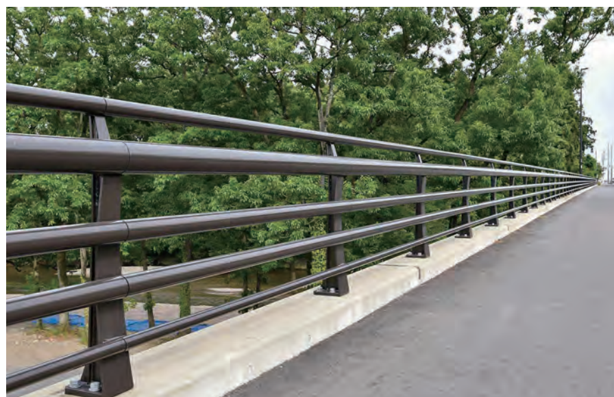
平沢橋／埼玉県 種別: B種 タイプ: モデスト 工事: 新設
