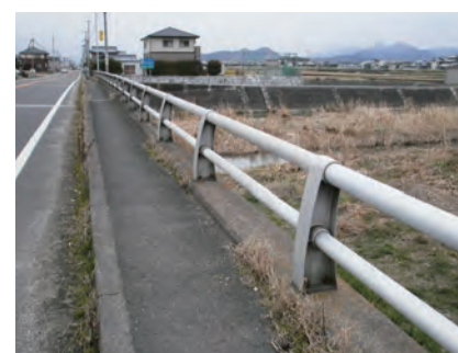
改修前 アルミ合金製高欄
