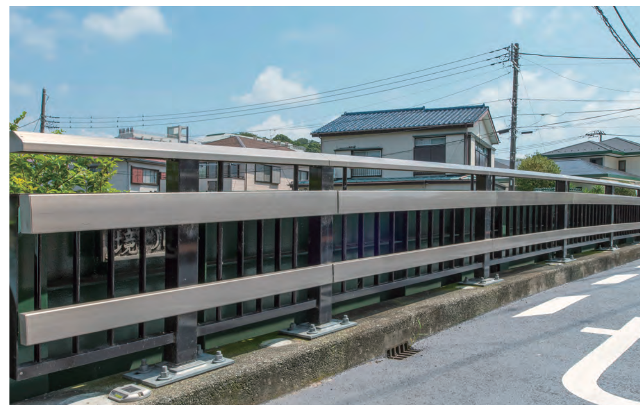
御殿橋／神奈川県 種別: C種 タイプ: アルミ合金製標準(改) 工事: 改修
