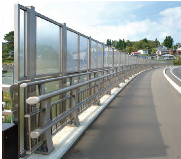
三沢大橋／青森県 種別: A種 タイプ: キャブローア+落下物防止柵(ポリカーボネート板) 工事: 新設
