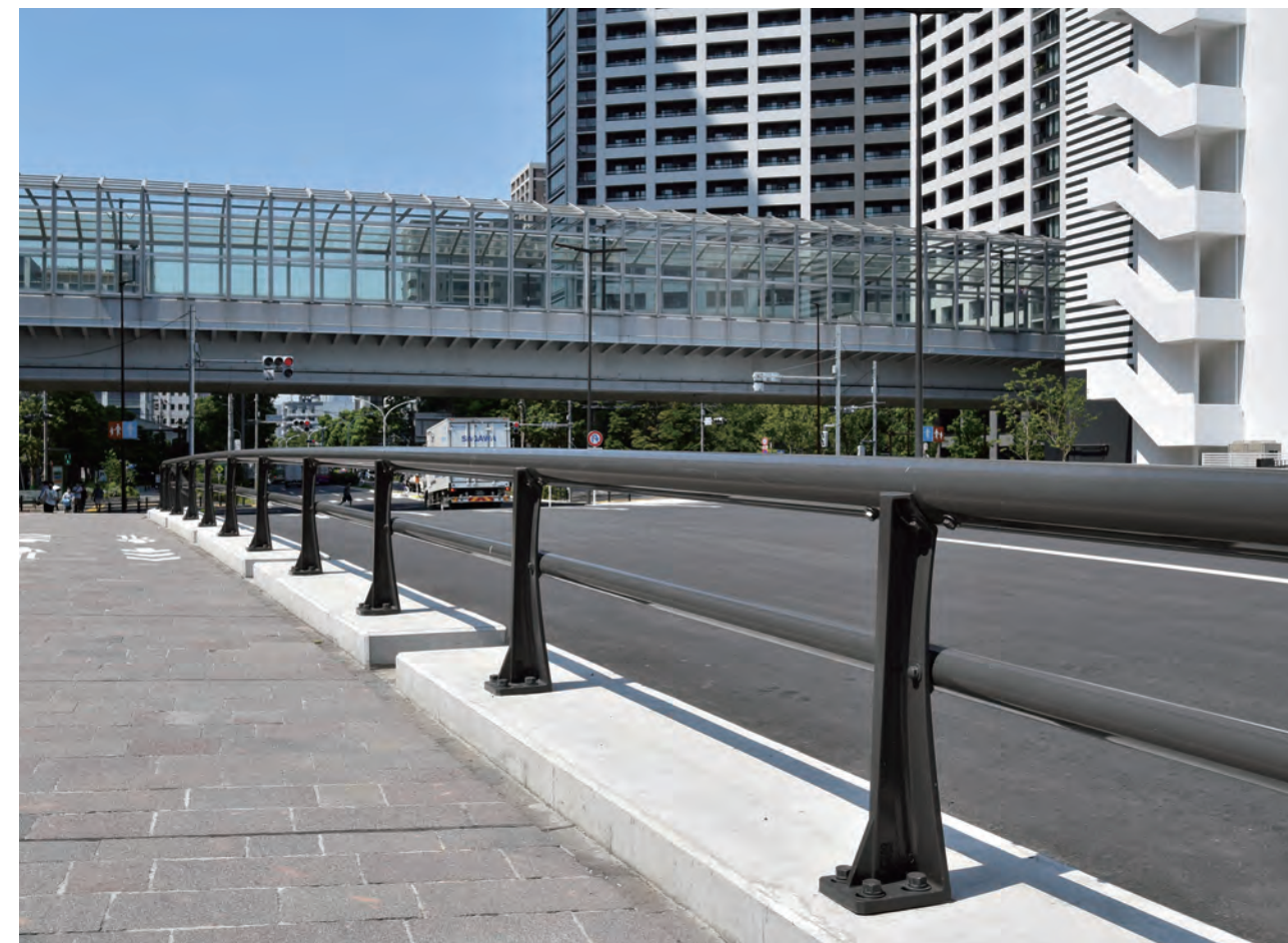
新島橋／東京都 種別:Bp種 タイプ:モデスト 工事:新設
