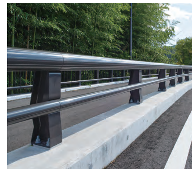
吾妻ふるさと大橋／群馬県 種別:Bp種・SP種 タイプ:鋼製標準 工事:新設
