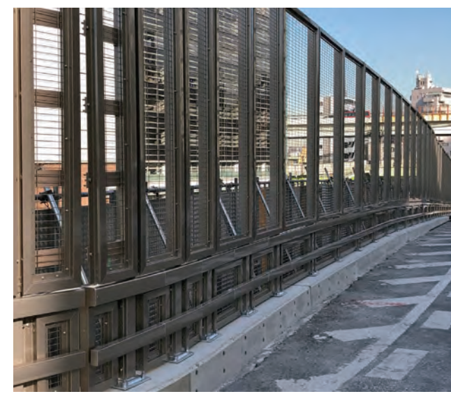
池袋大橋／東京都 種別: 積荷転落防止柵(F1) タイプ: アルミ合金製 工事: 改修
