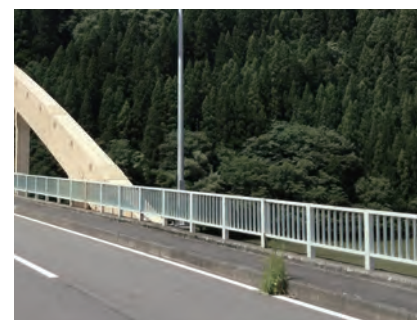
改修前 鋼製高欄
