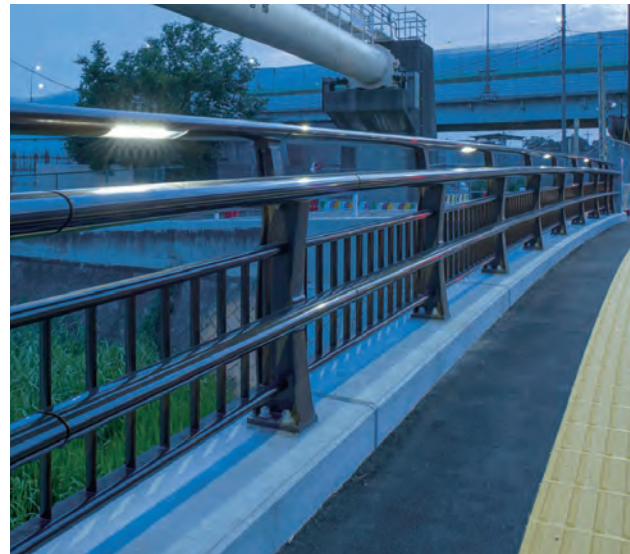
宝来橋／埼玉県 種別: C種 タイプ: キャブローア+LED照明内蔵 工事: 新設
