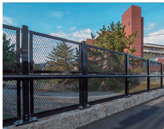
遊覧橋／滋賀県 種別: SP種 タイプ: アルミ合金製+落下物防止柵 工事: 改修
