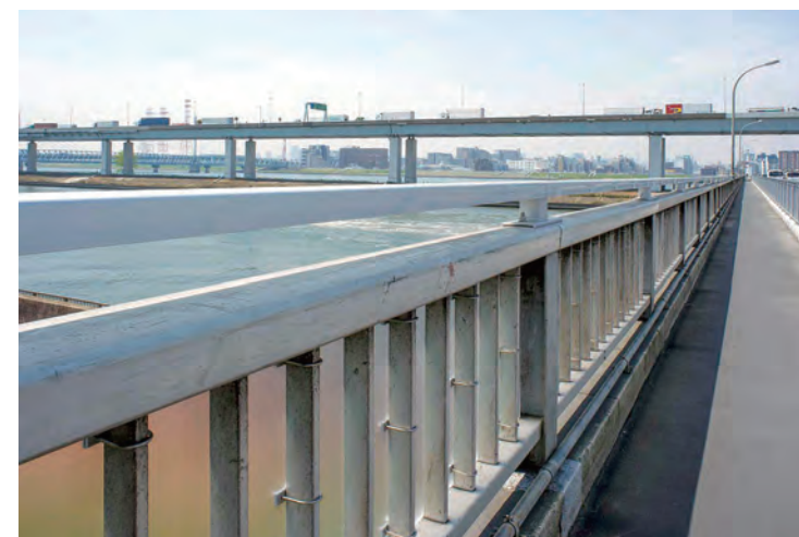
改修後 アルミ合金製高欄に嵩上げ
