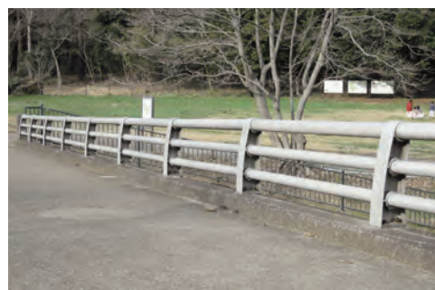
改修前 アルミ合金製高欄
