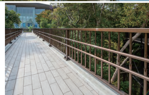
琵琶湖博物館歩道橋／滋賀県 種別:SP種 タイプ:アルミ合金製+デザインバスター+二段手摺 工事:新設
