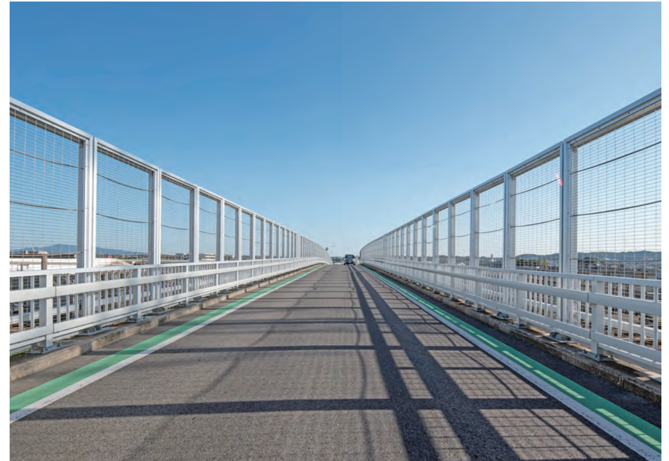
阿原跨線橋／愛知県 種別: 積荷転落防止柵(F1) タイプ: アルミ合金製 工事: 改修
