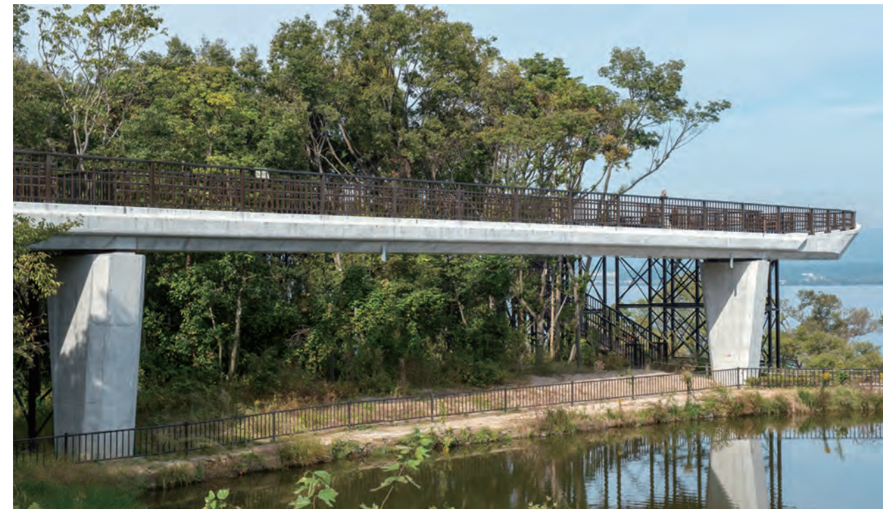
琵琶湖博物館歩道橋／滋賀県 種別:SP種 タイプ:アルミ合金製+デザインバスター+二段手摺 工事:新設
