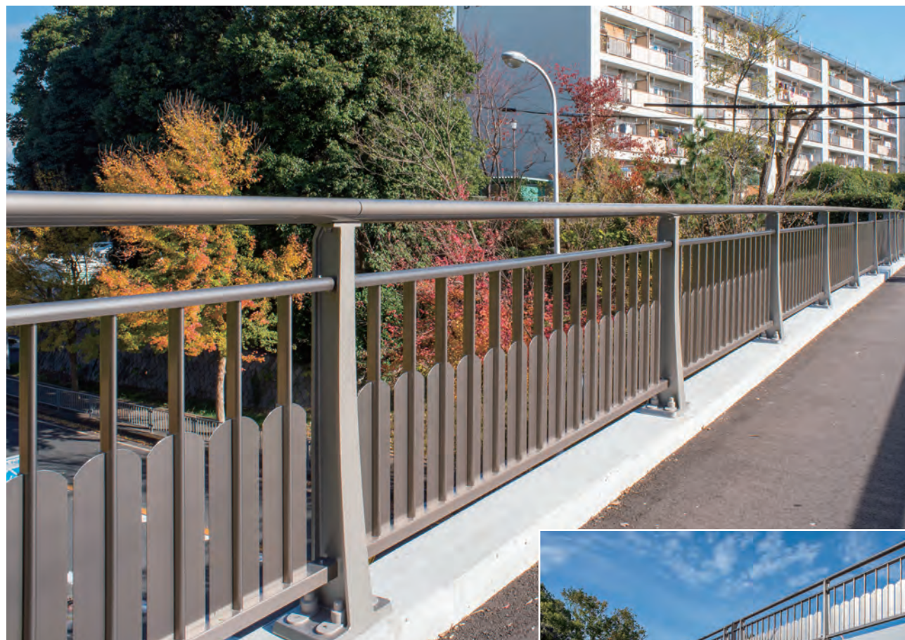
ざいふり橋補修/大阪府 種別: SP種 タイプ: キャブローア+裾隠し 工事: 新設
