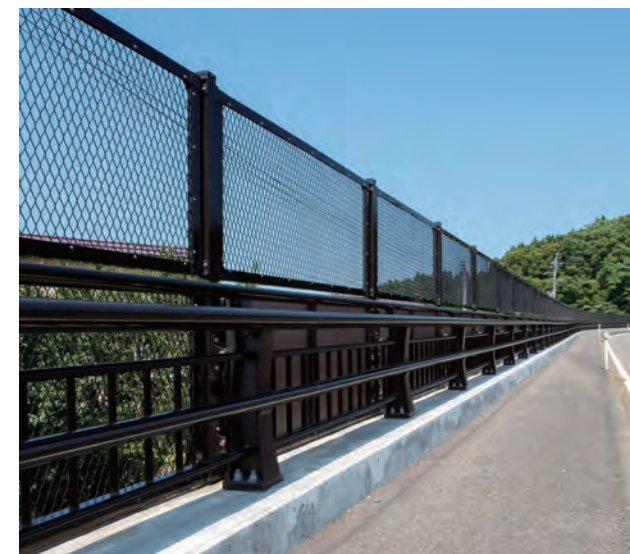
乙吉大橋／新潟県 種別: B種 タイプ: キャブローア+落下物防止柵(ラス網・ポリカーボネート板) 工事: 新設
