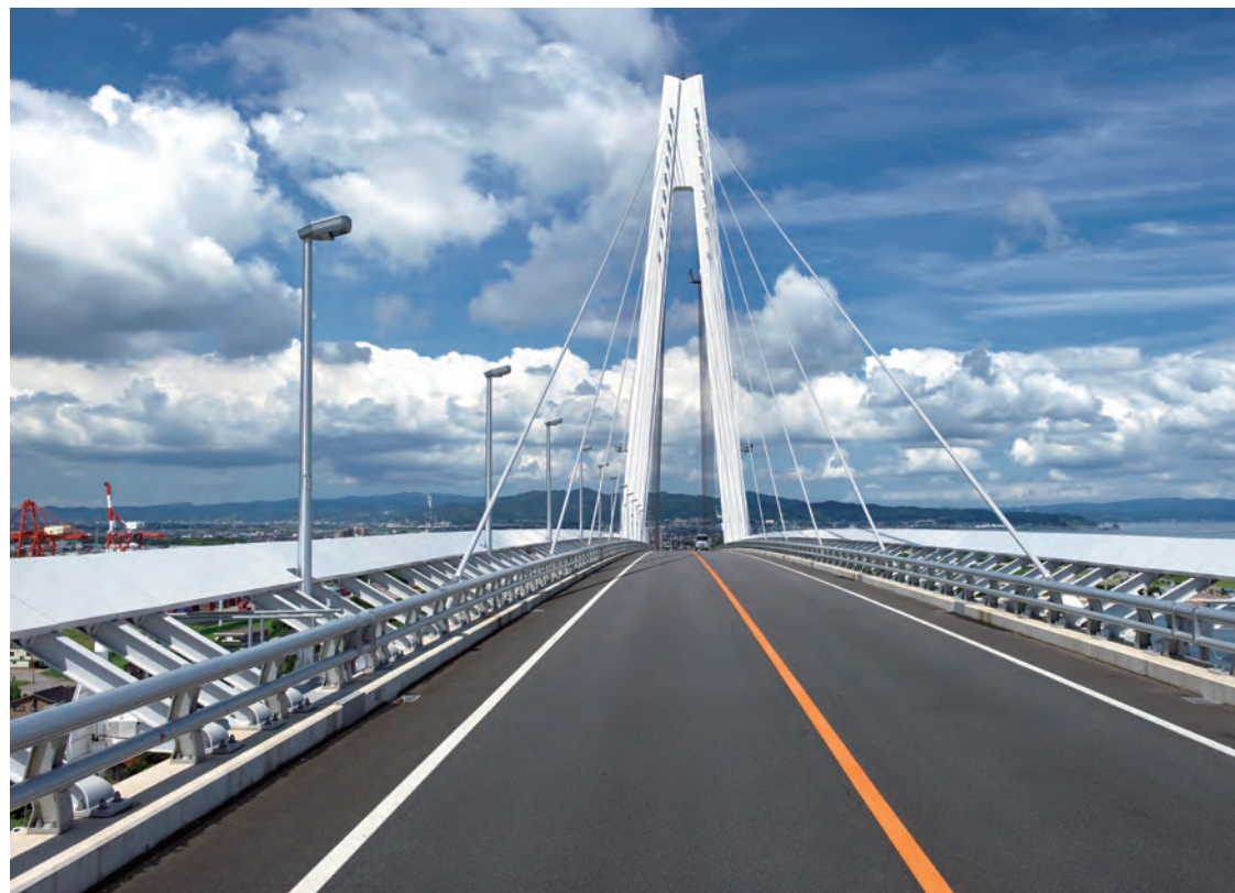
新湊大橋／富山県 種別:抑流板 タイプ:アルミろう付けハニカムパネル 工事:新設
