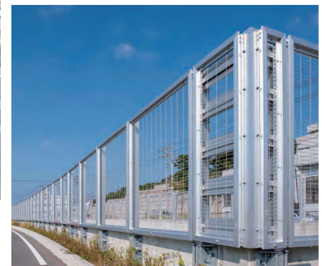
城間前田線積荷柵／沖縄県 種別: 積荷転落防止柵(F1) タイプ: アルミ合金製 工事: 新設
