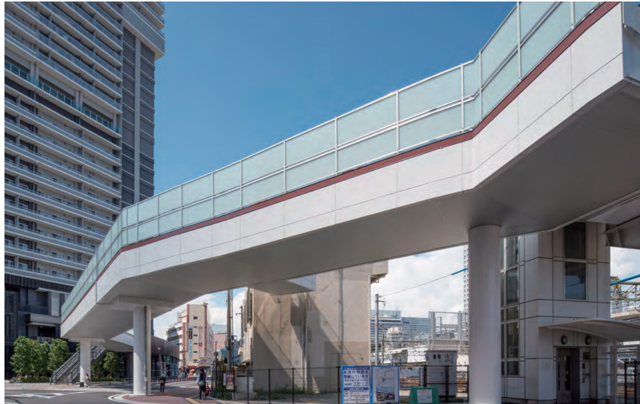
広島駅愛宕デッキ／広島県 桁側面:アルミパネル・桁下面:アルミスパンドレル 工事:新設
