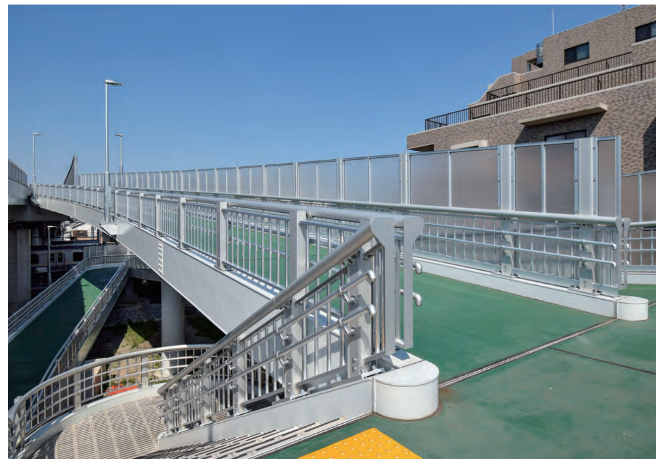
大船立体／神奈川県 種別: SP種 タイプ: アルミ合金製+落下物防止柵+二段手摺 工事: 新設
