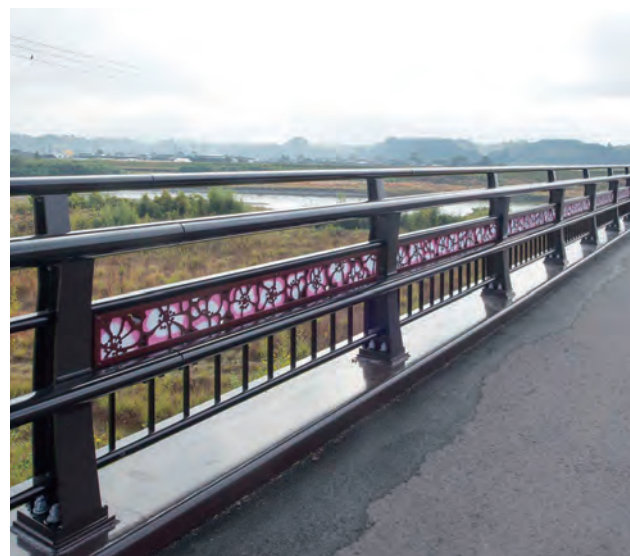
錦大橋／熊本県 種別:B種 タイプ:キャブロー+デザインパネル 工事:新設
