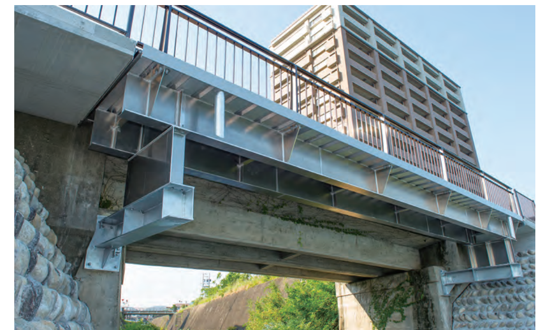
城見橋／岐阜県 コンパクトブリッジ・高欄: SP種キャプロア
