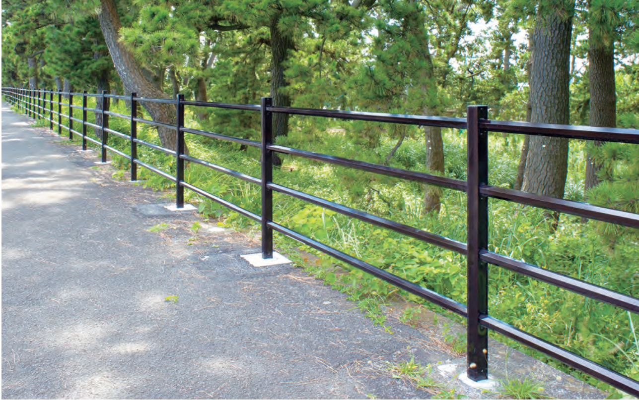
静岡清水自転車道／静岡県 種別: P種 タイプ: アルミ合金製標準 工事: 改修
