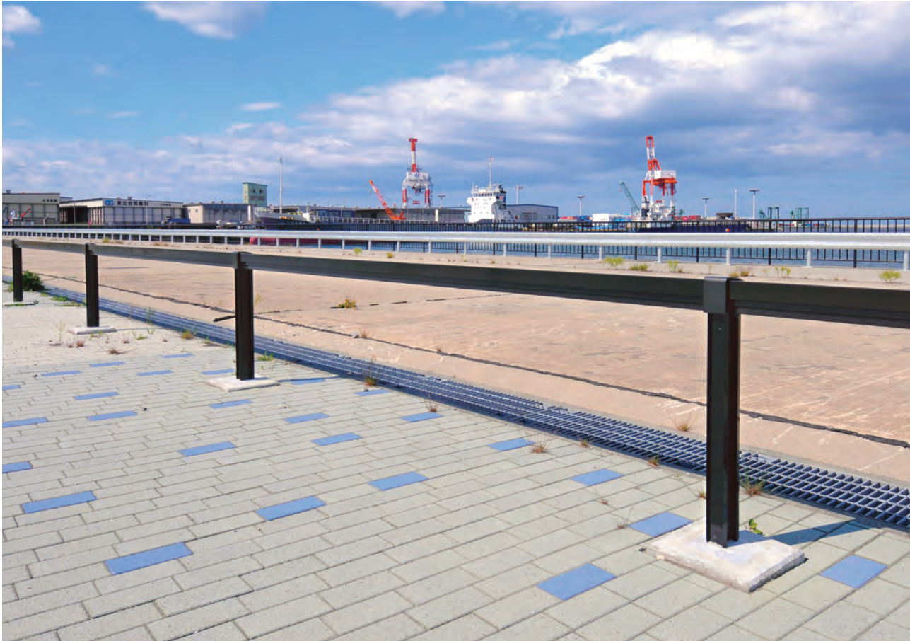
八太郎緑地 横断防止柵／青森県 種別: P種 タイプ: アルミ合金製標準 工事: 新設
