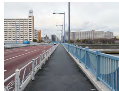
改修前 アルミ合金製高欄
