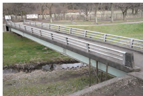
改修前 アルミ合金製高欄
