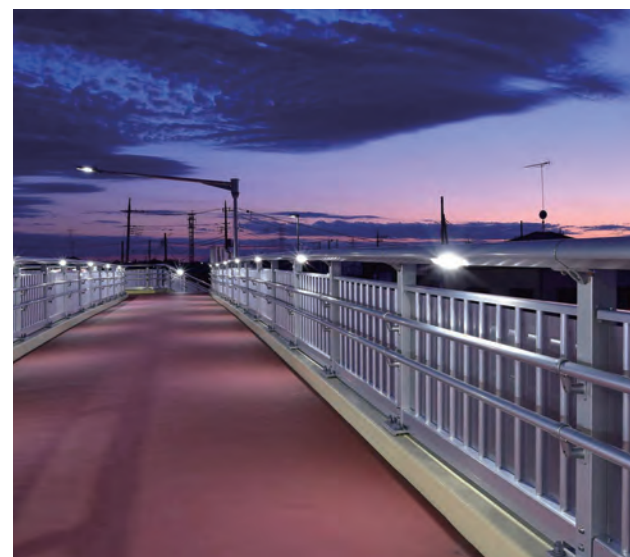
佐間歩道橋／埼玉県 種別: SP種 タイプ:アルミ合金製+LED照明内蔵+二段手摺 工事:新設
