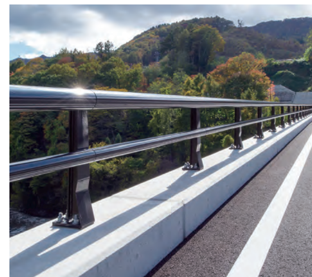
中央長野原橋／群馬県 種別:C種 タイプ:レイリスト 工事:新設
