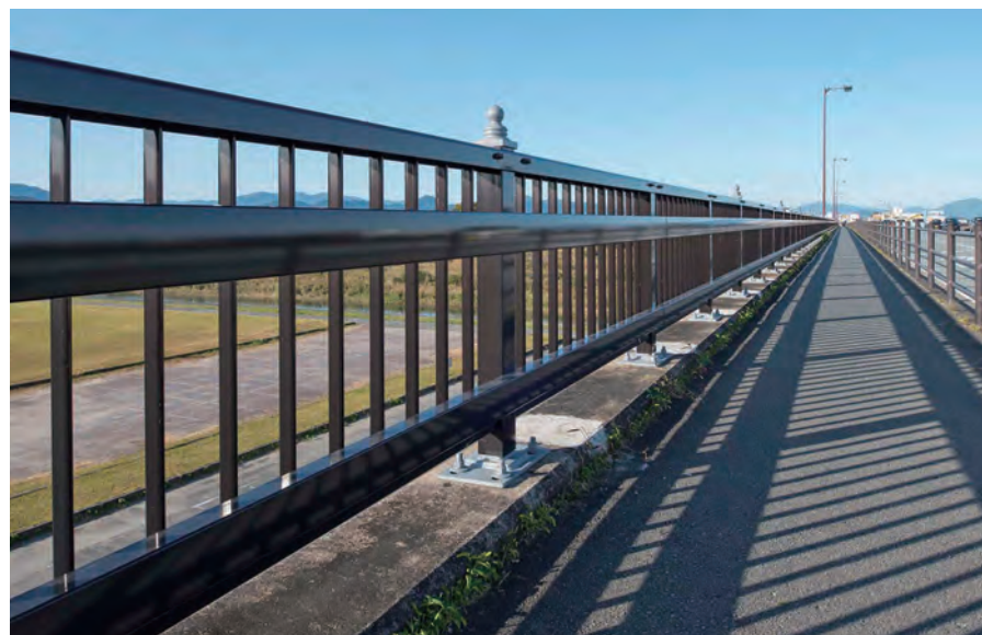
度会橋／三重県 種別: B種 タイプ: アルミ合金製標準(改) 工事: 改修
