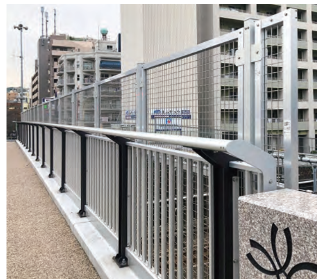
空蟬橋／東京都 種別: SP種 タイプ: アルミ合金製+落下物防止柵 工事: 改修
