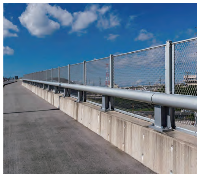
浦添西原大橋／沖縄県 種別: SB種 タイプ: アルミ合金製+落下物防止柵 工事: 新設
