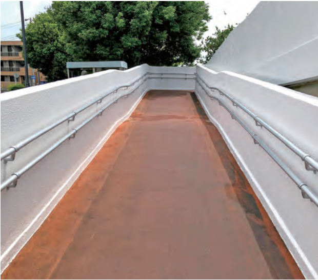
十日市場駅手摺／神奈川県 種別: 二段手摺 タイプ: アルミ合金製標準 工事: 改修
