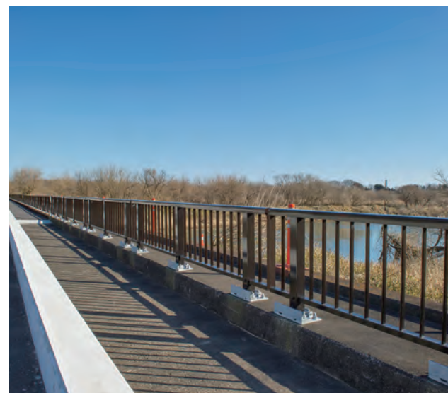
野渡橋／栃木県 種別:転倒式高欄 タイプ:アルミ合金製 工事:改修
