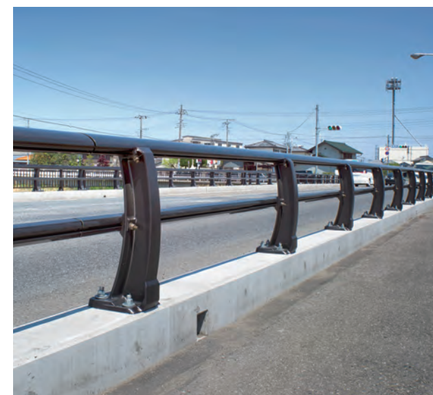
新波橋／群馬県 種別: Cp種 タイプ: キャブローア 工事: 改修
