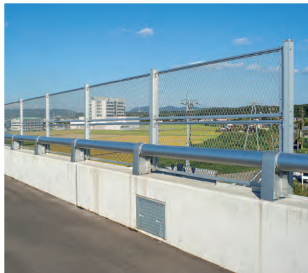
有帆川大橋／山口県 種別: SP種 タイプ: アルミ合金製+落下物防止柵 工事: 新設
