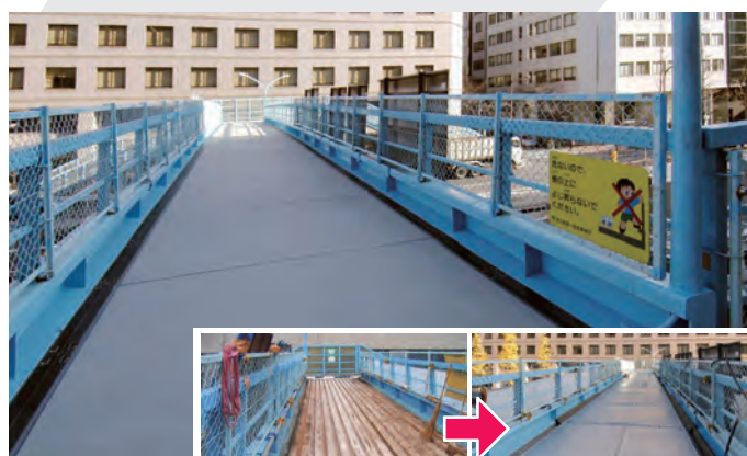
改修前／鋼製床版
