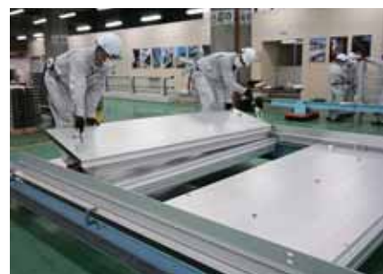
取り外し（設置後）
