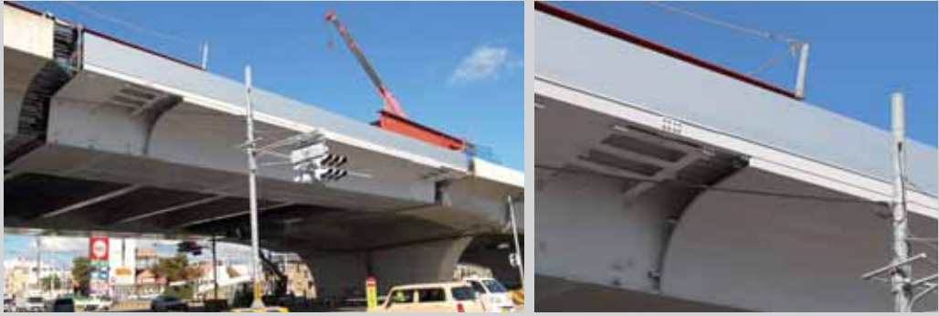
街路工事徳島県環状末広・住吉 高架橋：徳島県
