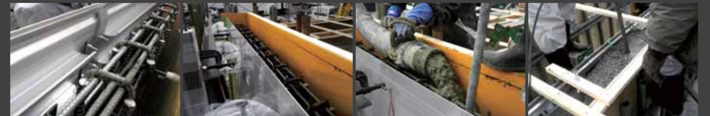
●残存型枠と配筋の状況
