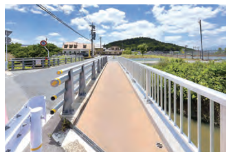
■エンス橋／奈良県（橿原市役所） 2021年度施工／W=1.5m L=16.6m 輸送制限により分割搬入、現地組立を行った事例です。
