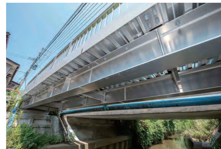
■柏崎市歩道橋／新潟県（柏崎市役所） 2018年度施工／W=1.5m L=9.6m
