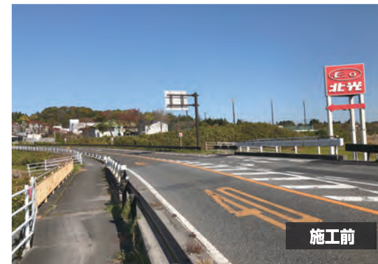
■萩沢川橋／宮城県 （国土交通省仙台河川国道事務所） 2020年度施工／W=2.0m L=14.0+4.1m
