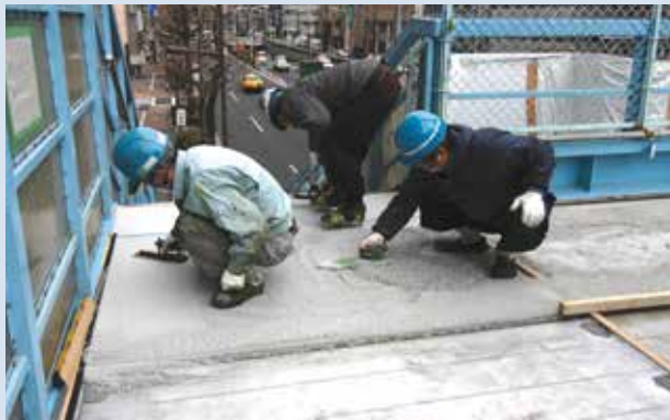
薄層舗装状況
