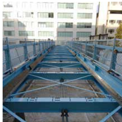
③アルミ床版取付金具セットと側溝の設置。再塗装も施す
