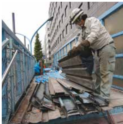
②デッキプレートは運搬できるように細かく溶断
