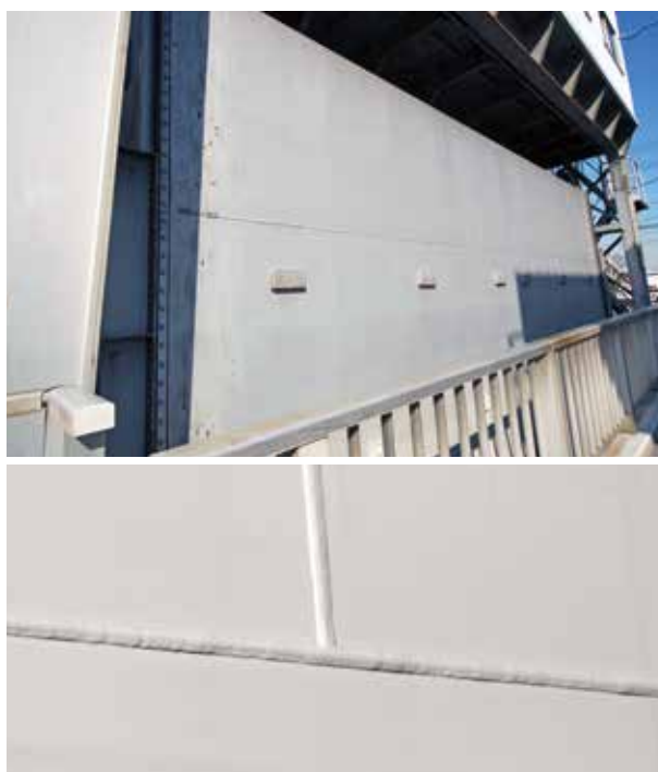
現場溶接された実績です。
