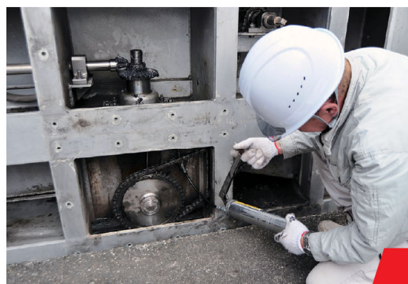
▲可動部のオイル補填
