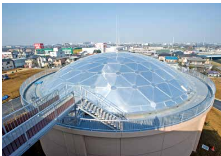
● 松伏北部配水場 埼玉県
