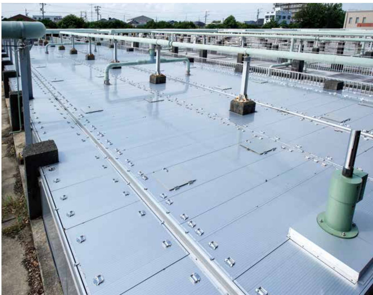
● 浜松市中部浄化センター 静岡県
