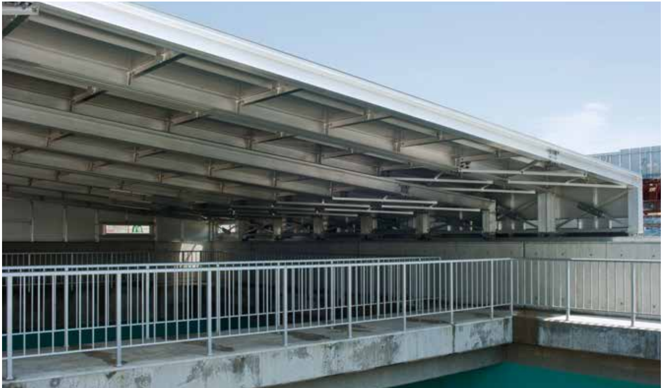
● 村野浄水場 大阪府
