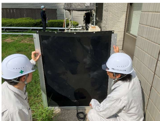
図1:検討中の工法を適用したフィルム型ペロブスカイト太陽電池
